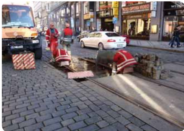
Zlikvidována byla také většina problémových a nefunkčních dilatací.
