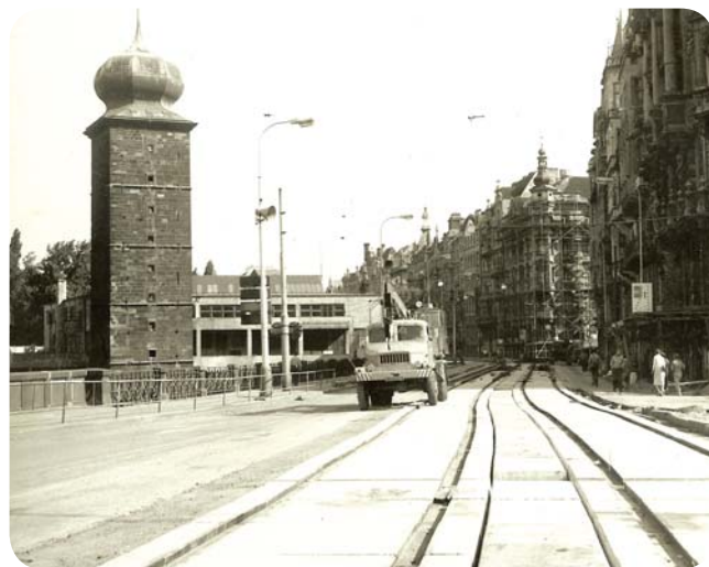
Foto z roku 1983 nám ukazuje stavbu tratě na Jiráskově náměstí. Právě tyto panely příští jaro zmizí. Foto: Archiv DP
