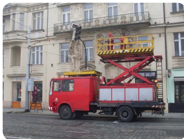
Likvidace staré elektricky ovládané výhybky u Mánesa. Foto: provoz 253400
