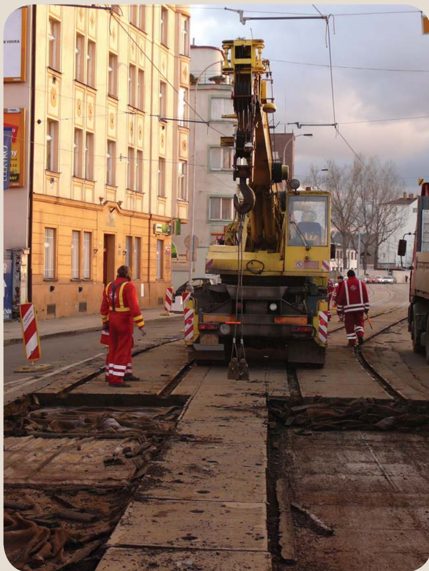
Po geotextilii panely „pěkně“ klouzaly, svévolný posun trati je dobře vidět mezi jeřábem a nákladním autem.
