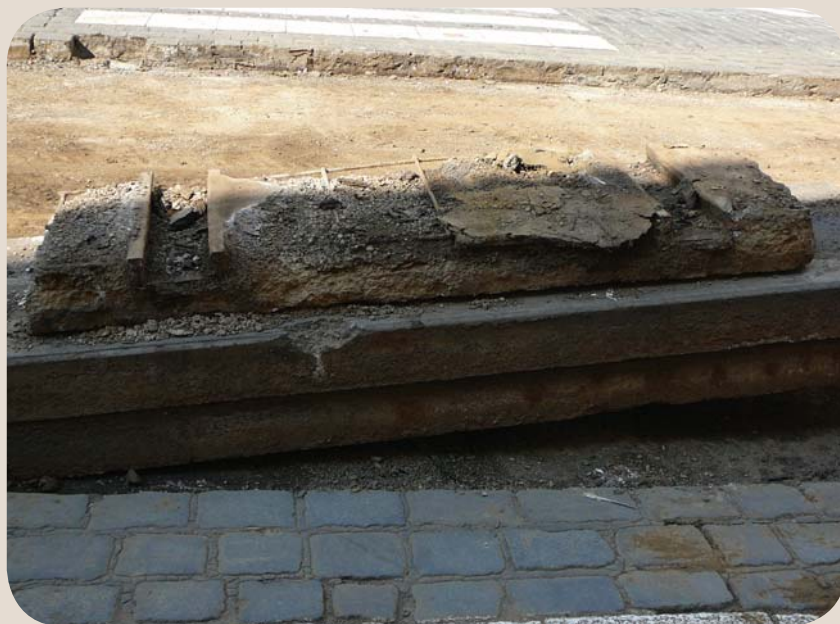
Zcela rozpadlé panely se nalézají v naší kolejové síti i dnes.
