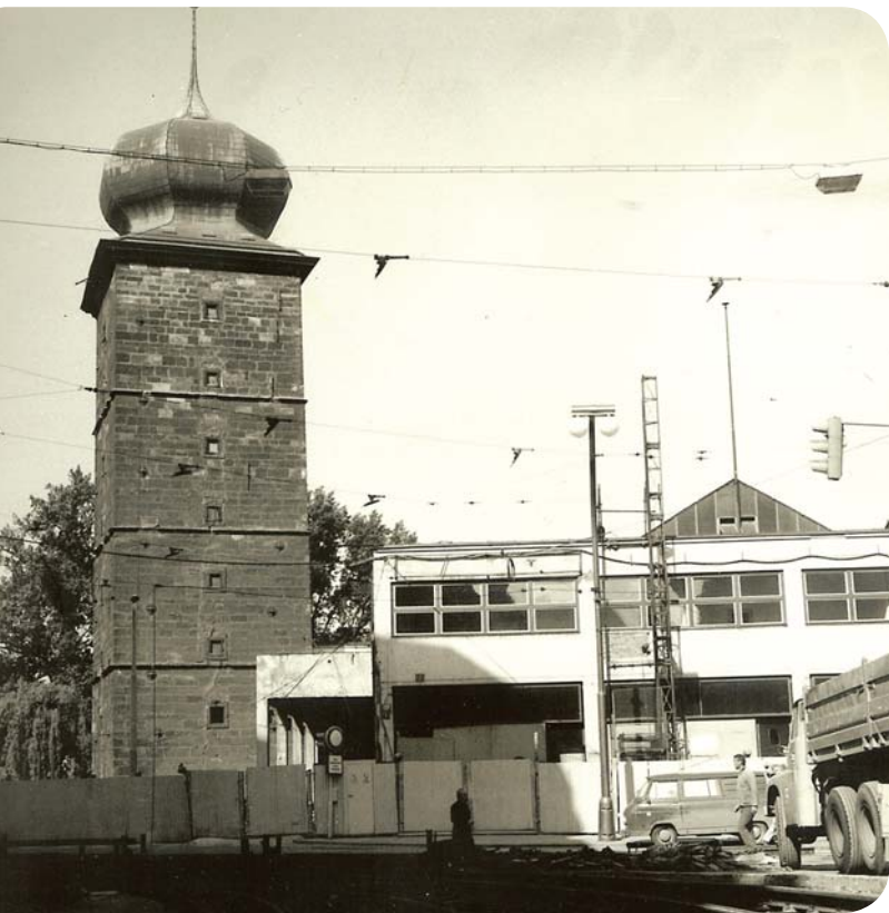
Rekonstrukce rozvětvení u Mánesa v roce 1983. Foto: Archiv DP
