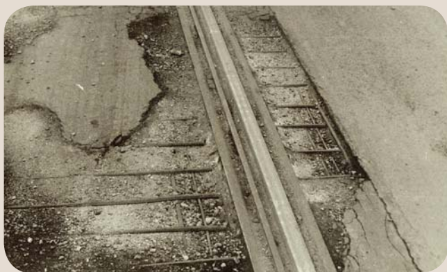
V 80. letech byly panely po několika málo zimách běžně takto zničené. Foto: Archiv DP
