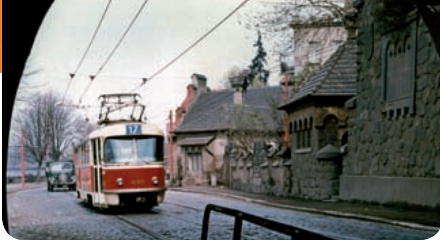
Píše se první polovina 60. let 20. století. Trolejové vedení připomíná, že tu jezdily i trolejbusy.
