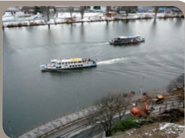
V neděli 23. listopadu již bylo nasněženo. Odra a Visla dělají společnost „drátěníkům“, kteří již montují trolej. Zbývají poslední desítky metrů živíc a litých asfaltů.
