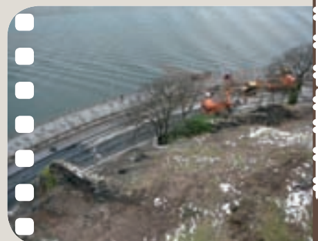
Konec třetího týdne. Zbývá asfaltovat část trati mezi tunelem a porodnicí.
