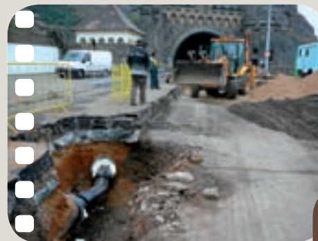
Nový plynovod byl protahován tím původním.
