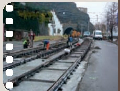
Šestý den. Nová trať s upevněním W-tram na betonové desce se již rýsuje.
