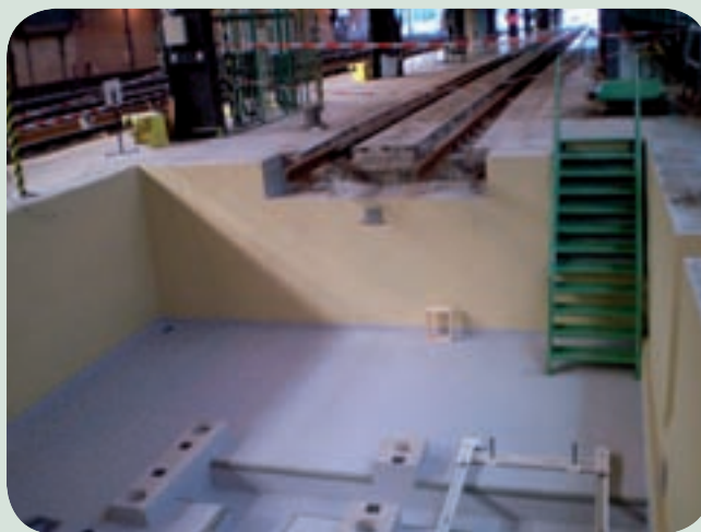
Celý prostor se před usazením soustruhu stavebně připravil.
