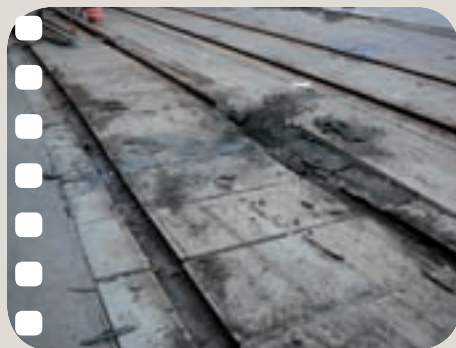
Zcela zničené BKV panely v průběhu demontáže staré trati.
