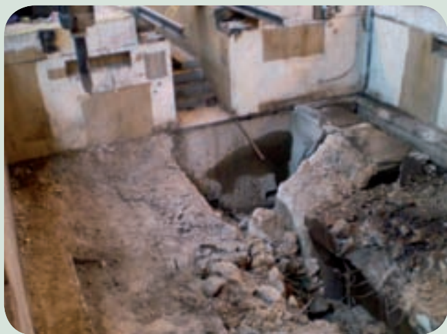
Nejdříve bylo nutno původní soustruh demontovat a prostor vybourat.
