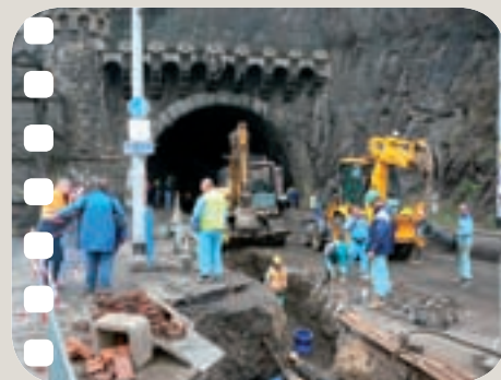
Stavba vodovodu, druhý den výluky.
