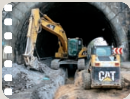
Frézování tvrdé skály v tunelu trvalo nekonečných 72 hodin.
