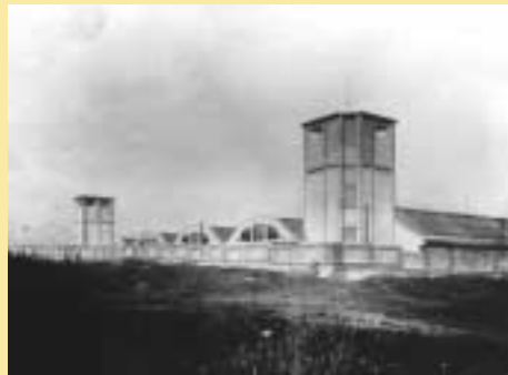
Dnes poněkud nezvyklý pohled na písková sila ve vozovně Pankrác z tehdy ještě neexistující ulice Na Veselí.
