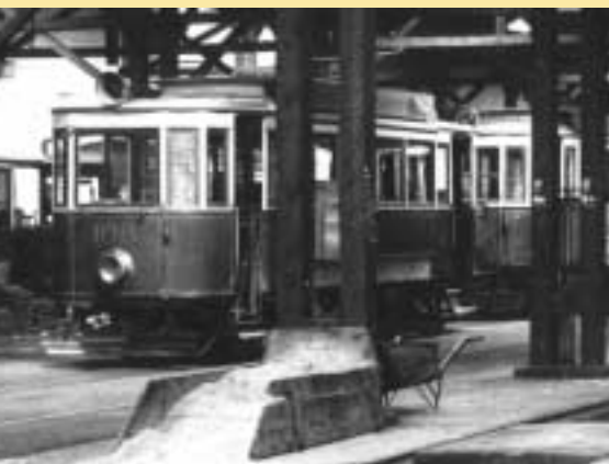
Bedna na písek ve vozovně Smíchov kolem roku 1922. Z takových (ale tvar není podmínkou) se doplňovaly zásoby v sypačích písku ve vozech. Ve srovnání se zařízením, o kterém jsme psali v minulém DP-KONTAKTu, se tu zcela jistě hodně prašilo.
