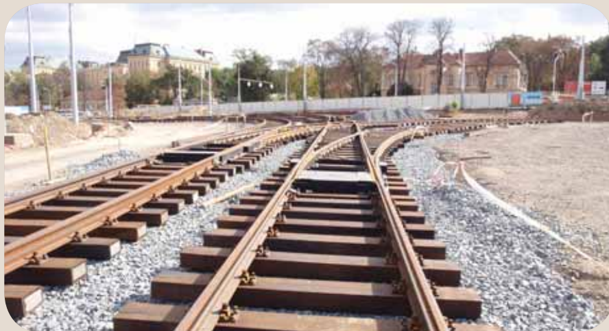
Provizorní oblouk z třídy Milady Horákové do Badeniho jen pár dní před zahájením provozu.
