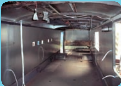
5 Vnitřek prázdného Kinobusu čekala ještě nová podlaha a stěny.
