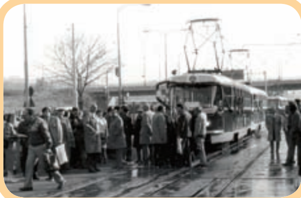
Zahájení provozu v zastávce Motol. 26. října 1988. Foto: Jiří Čermák
