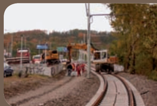
↑ Pražské kotvy přispějí k výrazně větší stabilitě kolejových roštů.
