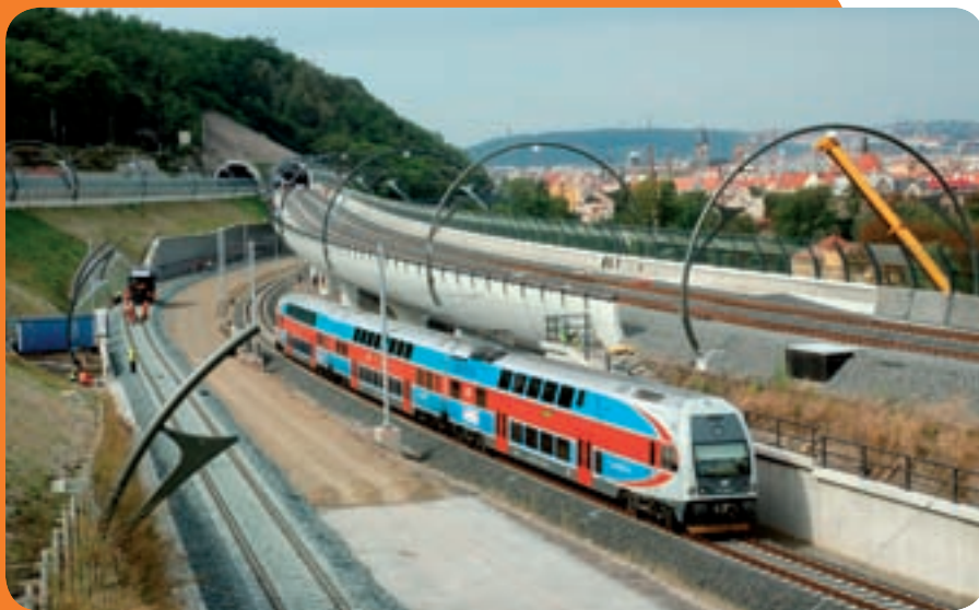
Díky dokončení Nového spojení bude výrazně zkrácena jízdní doba vlaků linky S2 mezi Vysočany a Masarykovým nádražím. Foto: Jiří Beněš
