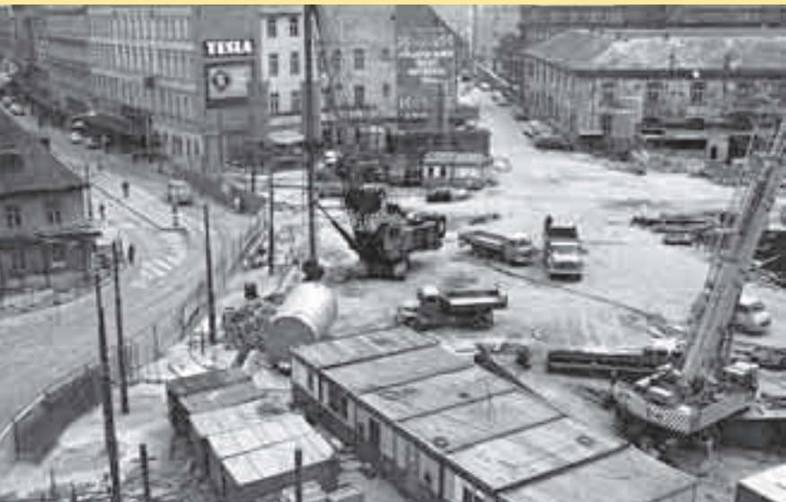
Stanice Náměstí Republiky má dva vestibuly. Jeden se budoval u nádraží Praha střed (dnešní Masarykovo), druhý na vlastním náměstí Republiky. Tramvaje se tady staveništi vyhýbaly na provizorních přeložkách. Nějaký čas se zde v krátkém úseku jezdilo i jednokolejně.
