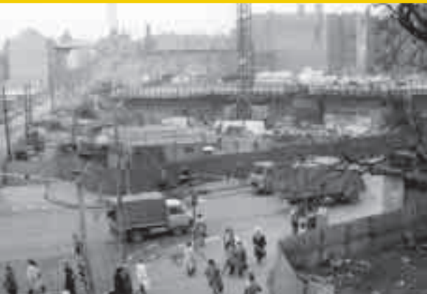
Při stavbě stanice Florenc (původně se jmenovala Sokolovská) muselo být zbořeno několik domů na nároží Sokolovské a dnešní ulice Ke Štvanici. Zde se budoval nový vestibul nejen pro trať B, ale i pro „céčko“.
