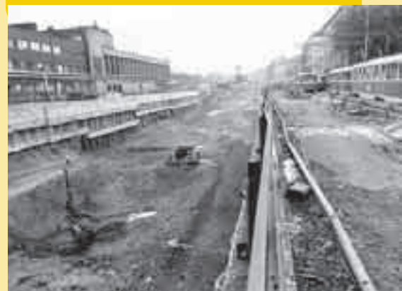
Konečná stanice Smíchovské nádraží byla i s obrátovými kolejemi budována jako hloubená. Tomu odpovídaly i rozměry stavební jámy. Tramvaje se dočasně přesunuly těsně k chodníku na východní straně Nádražní ulice a částečně jezdily po jedné koleji.
