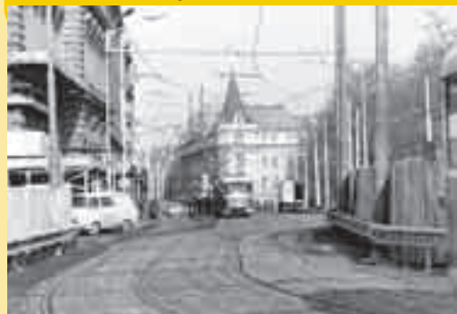
Na Karlově náměstí se stavěl jeden z vestibulů stejnojmenné stanice a podchod pod křižovatkou. Tramvaje tu projížděly po dočasných přeložkách mezi typickými ohradami z vlnitého plechu.
