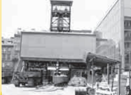
Při návštěvách obchodního domu jsme si několik let při jízdě po tamních eskalátorech prohlíželi těžní věž stanice metra, která vyrostla na místě zbořených domů. Dnes je tu povrchový vestibul stanice Národní třída.
