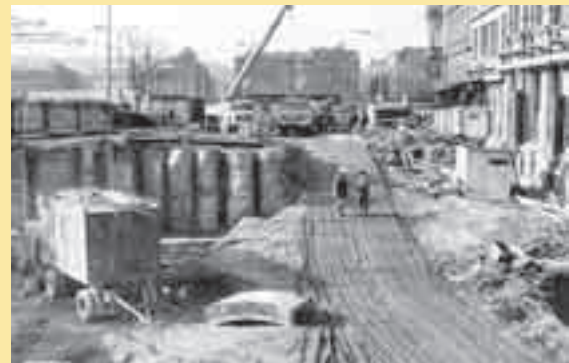
Druhý vestibul stanice Karlovo náměstí vyrůstal na Palackého náměstí. Ani zde se tramvajová doprava neobešla bez provizorních opatření.
