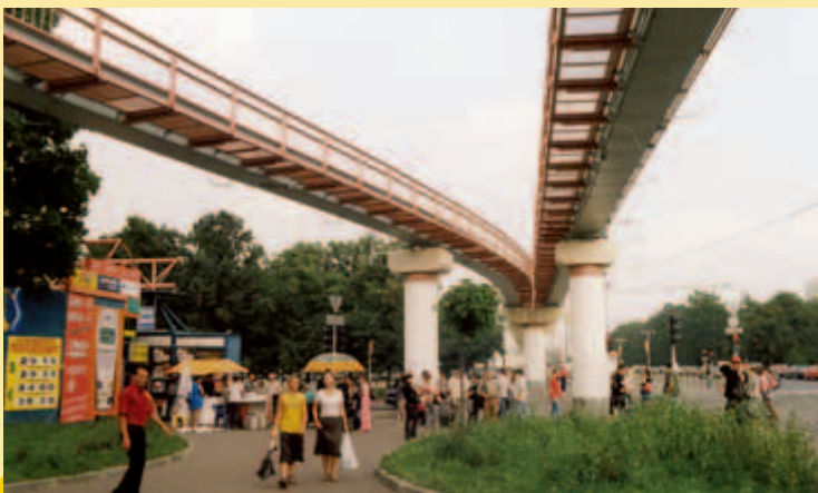
Estakáda jednokolejnicového dopravního systému.
