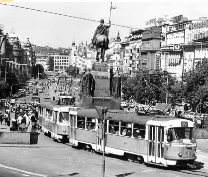
Václavské náměstí, jak ho mnozí z nás ještě pamatují. Od roku 1974 byly u stanice Muzeum vstupy do podchodu se stanicí metra. Dodnes, i 23 let po zrušení tramvajového provozu, jsou vlastně pozůstatkem bývalého přestupního uzlu mezi metrem a povrchovou dopravou.
