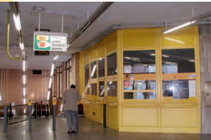
Ve vstupním prostoru je vše jako nové. Jenom fleky na stropě dají tušit, že zde původně bylo jiné osvětlení.
