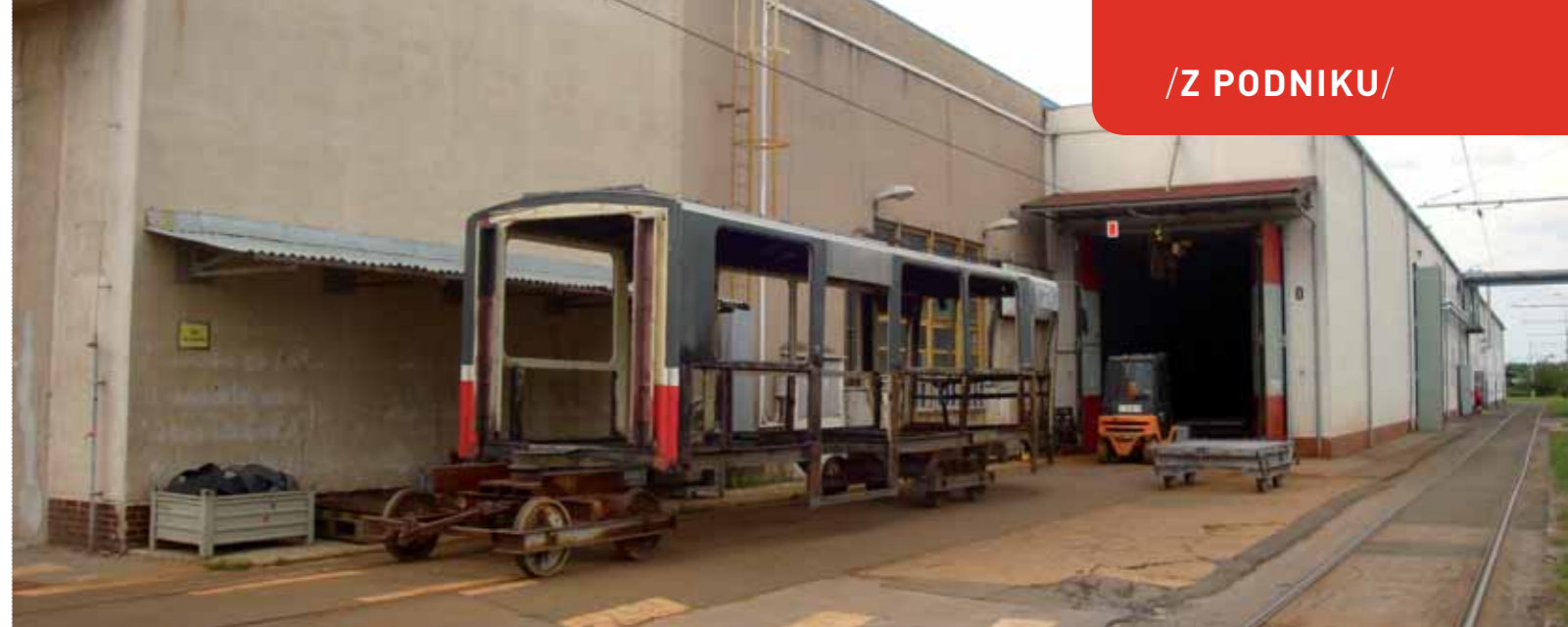
Otryskávací hala v přístavku opraven tramvaj v Hostivaři
