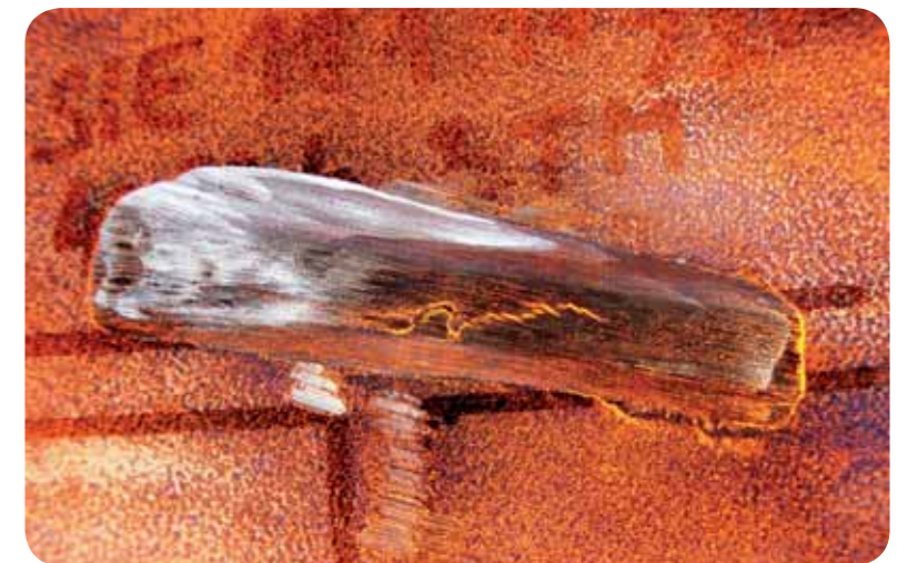
Zřetelné zviditelnění trhliny po vybroušení vady v hloubce 5 mm
