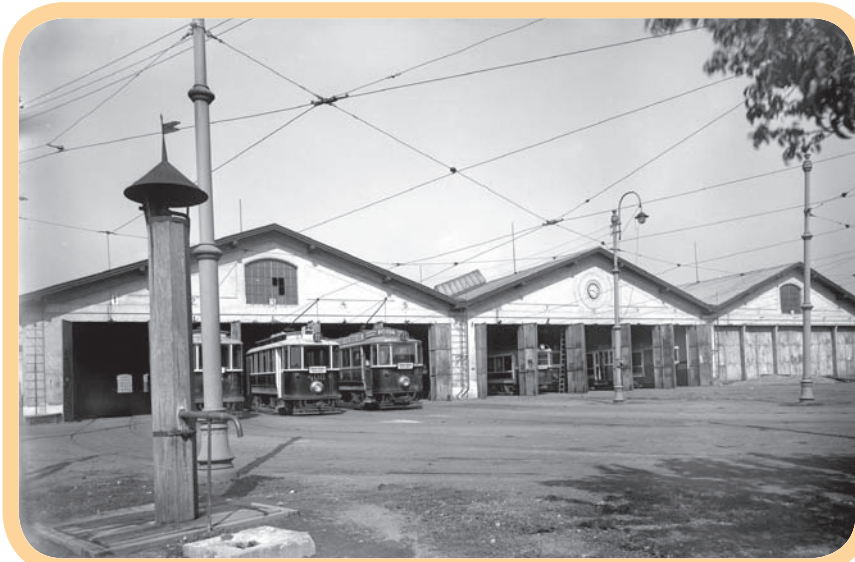
Strašnická vozovna (na snímku) měla jednotlivé lodě v jedné rovině, střešovická vozovna má třetí (a později i čtvrtou lod) vzhledem ke složitějšímu terénu níž.
