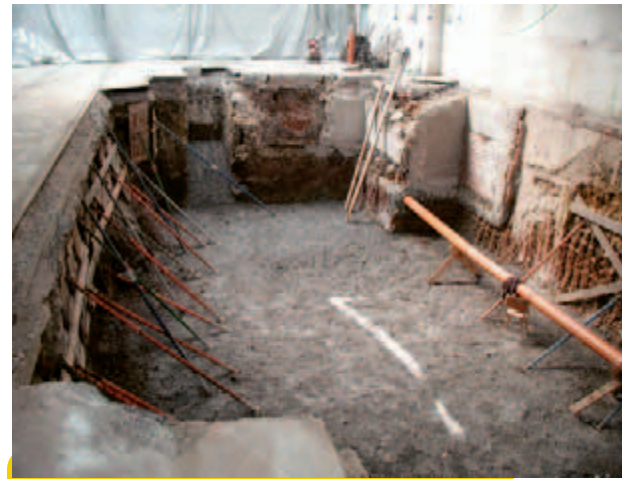
Ohromná jáma na začátku...
