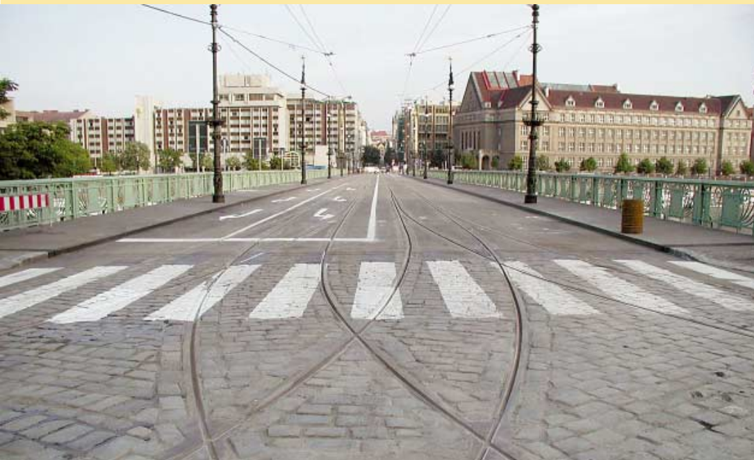
Celkový pohled na dokončený most před zahájením provozu.
