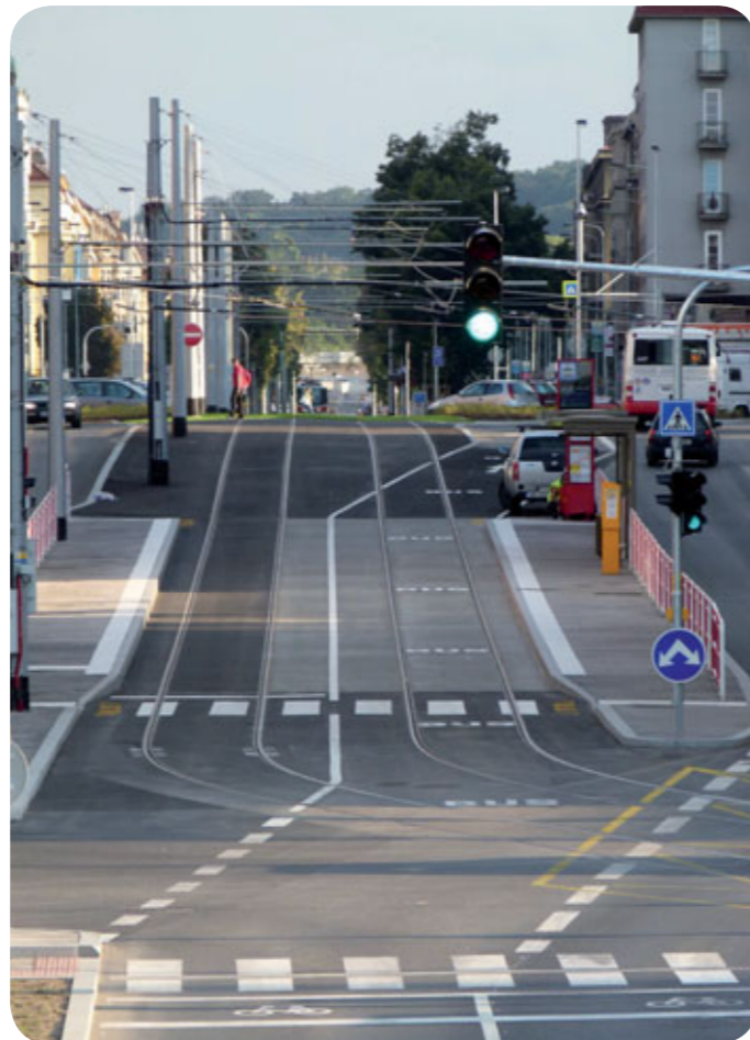
Unikátní kryt. V zastávce Podbaba do centra, kde jezdí i autobusy, je zřízen odolnější cementobetonový kryt trati
