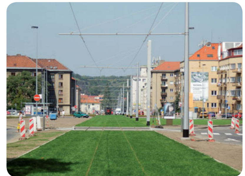
Místem bývalé smyčky projíždějí tramvaje již přímo, a to na železobetonových pražcích ve štěrku se zatravněním
