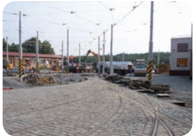
V první půli srpna už bylo mezi 1. a 5. kolejí v zásadě hotovo.
