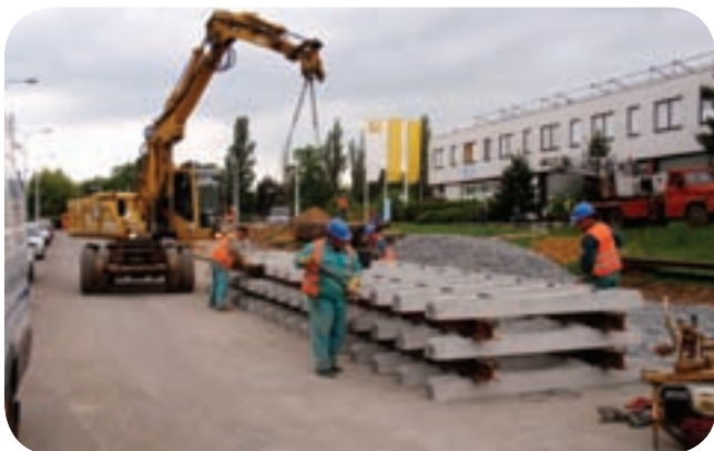
Jedna z dodavatelských firem provádí předmontáž kolejových polí přímo na staveništi způsobem obvyklým na „velké“ dráze.
