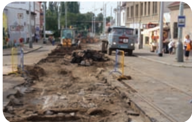
Ve třetí etapě pokračovaly práce už jen ve větvi k vozovně Kobylisy. 22. června 2009 probíhala demolice trati...
