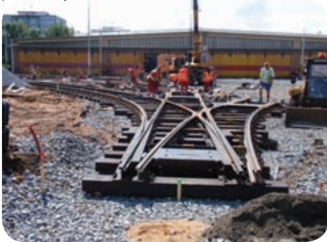
Jsme ve čtvrtině vyluky a před námi se klubou rozhodující výhybky dvora.
