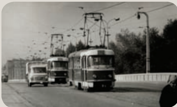
Libeňský most 1. října 1972 plný tramvajů na celkem chatrné trati. Foto: Jiří Čermák.
