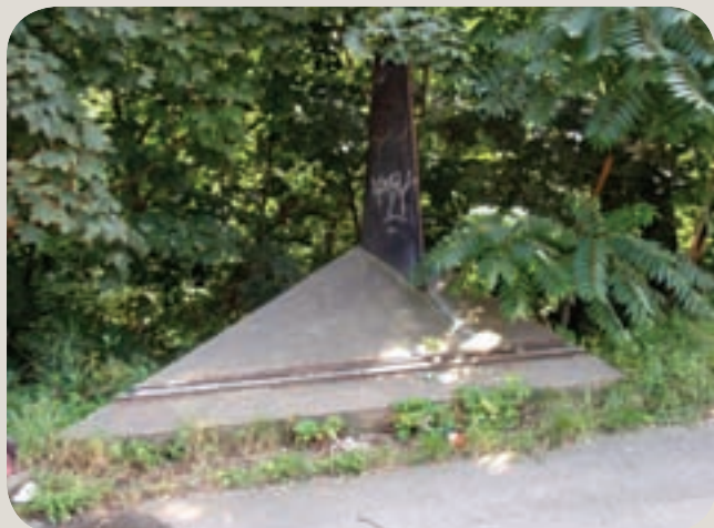
Torzo pomníku „100 km tratí v BKV panelech“.
