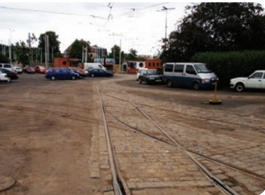
Pohled na původní stav dvora, na snímku je vidět severní kolej v pozadí zakončená kruhem.
