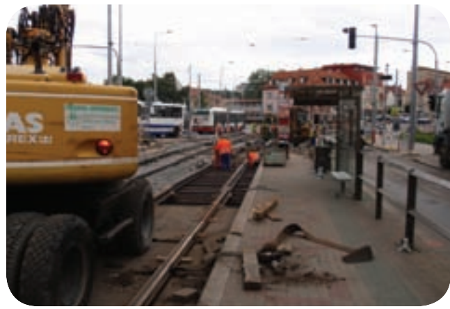
Druhá etapa, při níž byla pro tramvaje uzavřena celá křižovatka, byla časoprostorově zdaleka nejsložitější.
