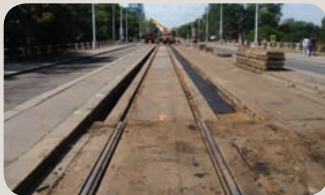
Jeden z několika úseků, kde byl obnoven svršek trati.
