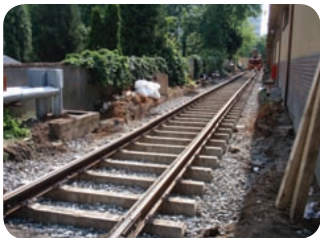
Již v květnu a červnu, tj. za provozu vozovny, probíhala rekonstrukce objízdné koleje.
