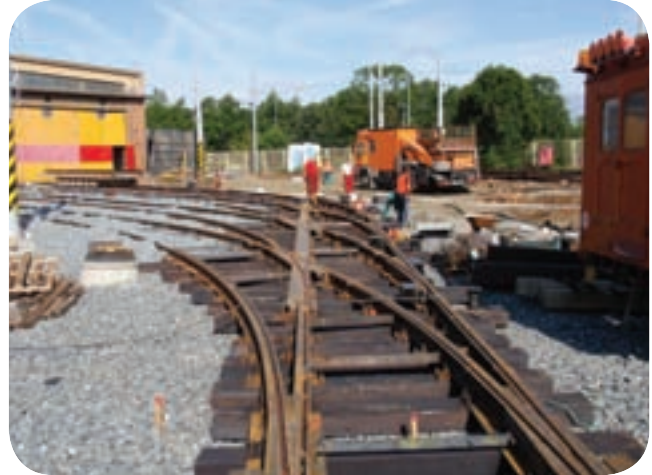
Začátkem srpna byly položeny koleje téměř na celé Haršě...
