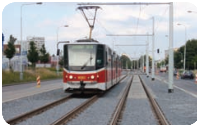
Zkušební jízda vozem KT8N2 byla zadokumentována dva dny před obnovením provozu mezi zastávkami Ládví a Kyselova v místě, kde je v krátkém úseku užitá betonová deska.
