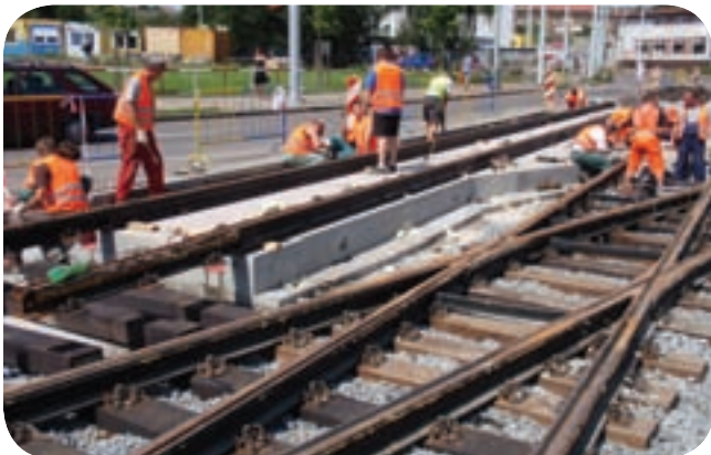
Kolejnice bude v budoucnu možno vyměnit, v daném místě ale bude spíše limitující „výdrž“ povrchu panelů než-li kolejnic.
