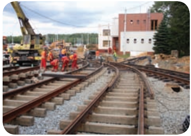
Již 3 dny poté se začaly rýsovat na dvoře první nové koleje.
