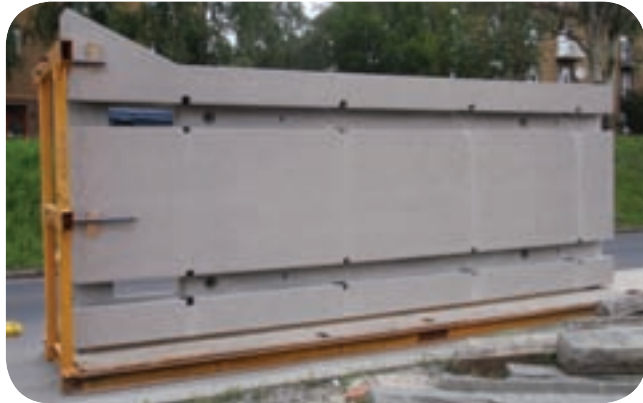
Velkou zajímavostí této rekonstrukce je zkušební užití velkoplošného panelu od německé firmy Max Bögl. Panely se vyrábějí na míru a jsou osazeny normální kolejničí NT1.
