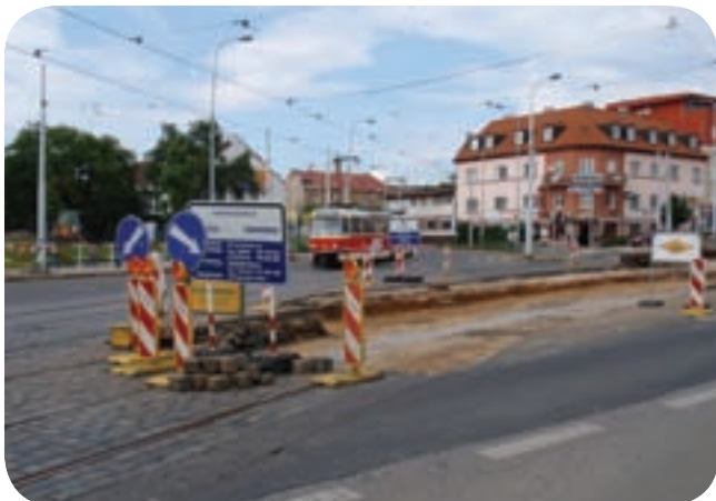
Na velké investiční stavbě v Praze jde svým způsobem o novinku: v části křižovatky se pracuje a po zbytku jezdí tramvaje – 2. června...
