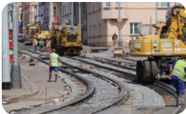
...a 10. srpna 2009 zde již pracovala podbíječka. Velkou novinkou této lokality bude rozjezdová splítka, která odstraní dlouholetý problém s nadměrným ojížděním rozjezdové výhybky směrem ke Stírce.
