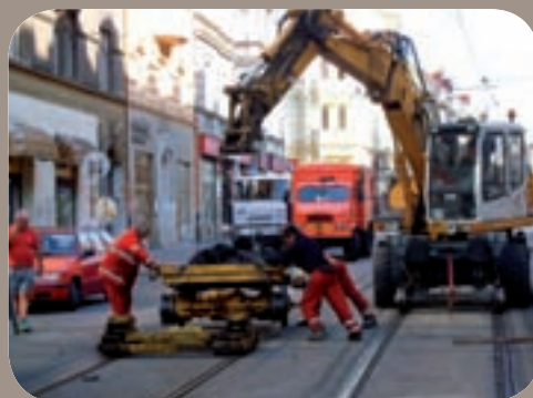
... a přípravy na zatlačování gumy do kolejnic. Foto: Tomáš Šilhan
