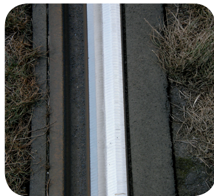
Kolejnice bezprostředně po reprofilaci.
