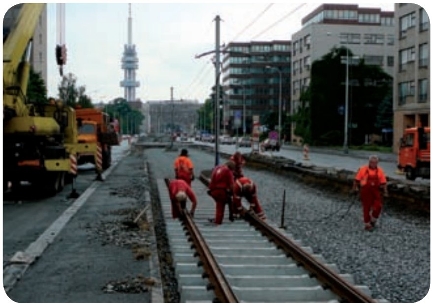
Pokládání předmontovaných kolejových polí.
