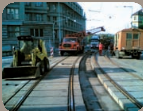
Neděle 17. srpna 2008 ráno. Probíhá osazování posledních kolejnic...
