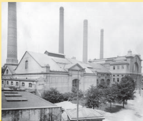
Celek nádvoří holešovické elektrárny v první polovině 20. let 20. století. Dominantním objektem byla vlastní elektrárna, tj. kotelna se čtyřmi komíny a strojovna, ve které byla i výroba trakčního proudu.
