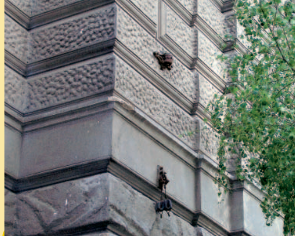
Zbytky závěsů trolejového vedení pro tramvaje zdobily budovu strojovny bývalé elektrárny ještě na konci května 2005...
