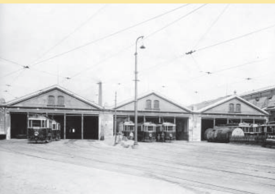
Přibližně ze stejné doby jako předchozí snímek pochází i fotografie vozovny. Měla tři lože po pěti kolejích. Vozovna zahájila provoz 2. července 1900.
