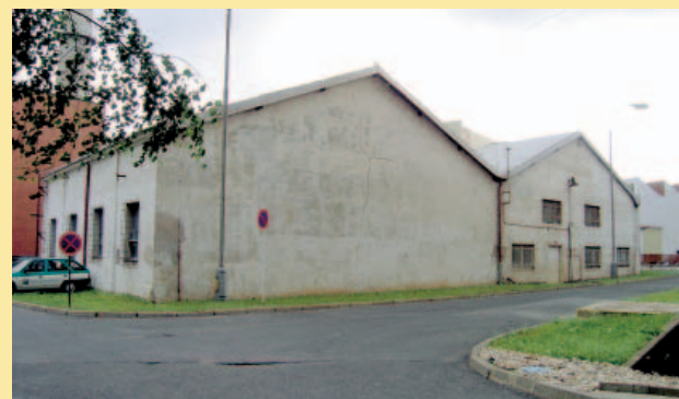
A tak vypadala někdejší tramvajová vozovna Centrála 31. května 2005. V roce 1977 byla část vozovny zbořena, aby ustoupila výškové administrativní budově. Dodnes zbyly jen části první a druhé lože.
