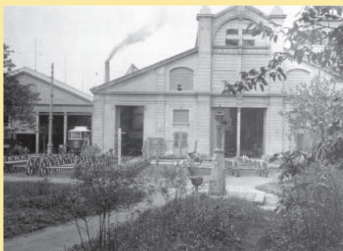
A ještě jeden snímek A. Novotného. Budova ústředních tramvajových dílen v roce 1914 krátce před jejich stěhováním. Vraty vlevo, vedle vozovny, vedla kolej do lakovny. Dvoje vrat uprostřed dílen vedly dvě koleje do vlastní opravy tramvají.
