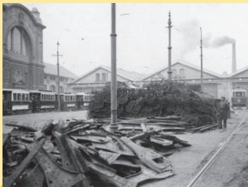
Jiný snímek A. Novotného 19. března 1914 ukazuje doslova obložený demontovanými součástmi ochranných rámu systému Svoboda-Jirgl-Charvát a podvozků typu maximum traction.
