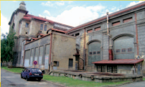
V areálu holešovické elektrárny najdeme dnes, půl století po odpojení posledních nákladových kolejí, i další pozůstatky připomínající tramvajovou éru. Například toto je dnešní stav rampy na transformátory, na kterou se transformátory dopravovaly tramvajemi. Koleje už v areálu nenajdeme.
