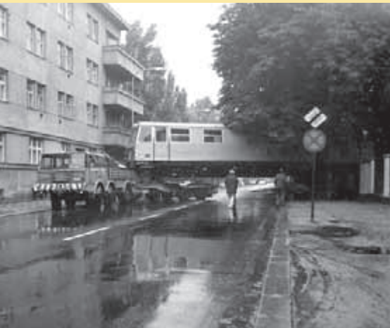
Tahač Tatra se speciálním přívěsem, na kterém je uložen svařovací vůz K-355PT, vyjíždí z areálu někdejších vojenských zásobáren do Kovpakovy ulice (ta dnes nese jméno Generála Píky). Jak se vůz dostal do vojenského areálu vybaveného železniční vlečkou? Po vlastní ose jako součást speciálního vlaku?
