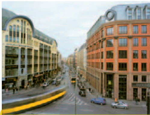
Berlínské tramvaje před Hackesche Höfe, obchodním centrem z roku 1905, které o ploše 10 000 m 2 ve své době bylo jedním z největších svého druhu v Evropě. Příkladná rekonstrukce pochází z let 1995 až 1996.
