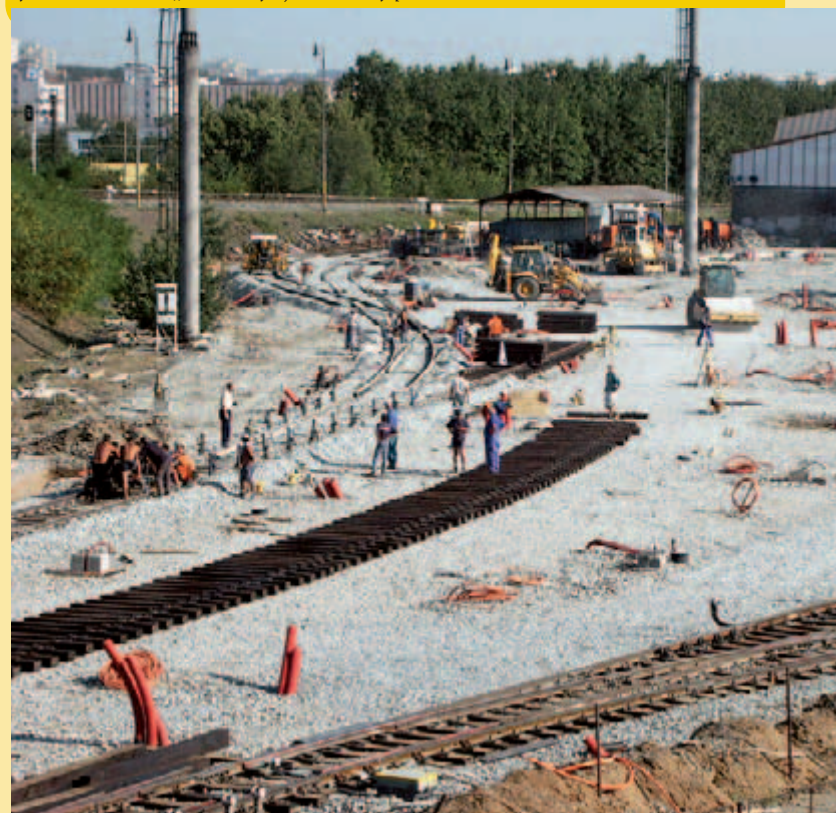
Do levé části haly bude situována nová stanice. Kolejistiše se upravovalo pro zvýšenou rychlost. Červené „husí krky“ jsou určeny pro vedení kabelů.
