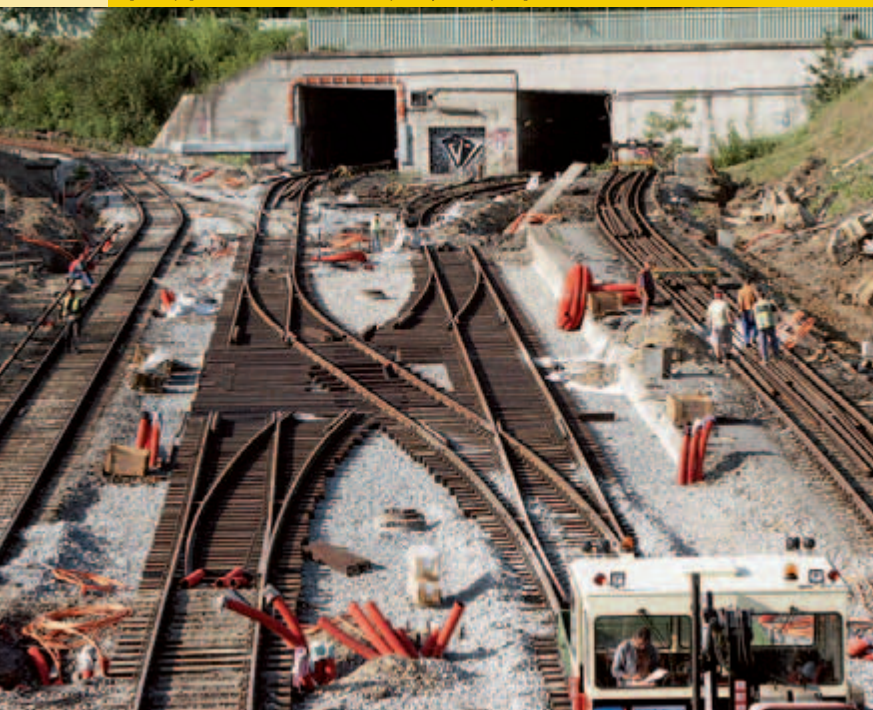
Opačný pohled směrem od haly k vjezdovým portálům.
