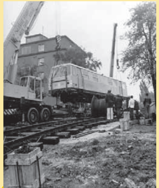
Zde byl vůz vyzdvižen dvojicí jeřábů a usazen na provizorní kolej...
