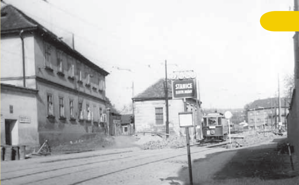
V první polovině 70. let začaly probíhat úpravy na třídě Rudé armády mezi Čimickou a Střelničnou ulicí. V místě na snímku je dům U Sokola; dnes je právě tady východní vestibul stanice metra Kobylisy. Foto: J. Kirnig
