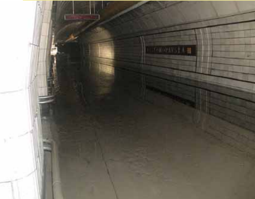
Zvláštní a ojedinělý pohled na stanici Českomoravská, chybí pouze člun či jiné plavidlo...
