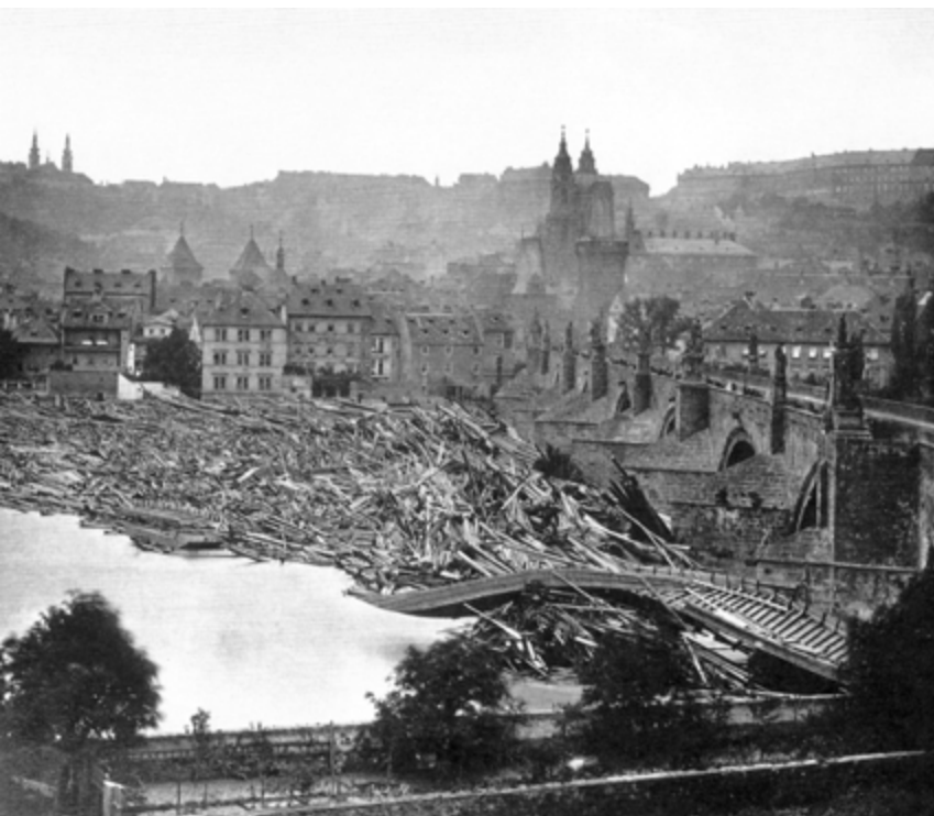
Tak vypadal Karlův most po povodni v květnu 1872. Obrovské množství klád voda přinesla především z pražského Podskalí a nedalekých pil na obou březích řeky. Naplavené dříví působí až strašidelně. Foto: František Fridrich
