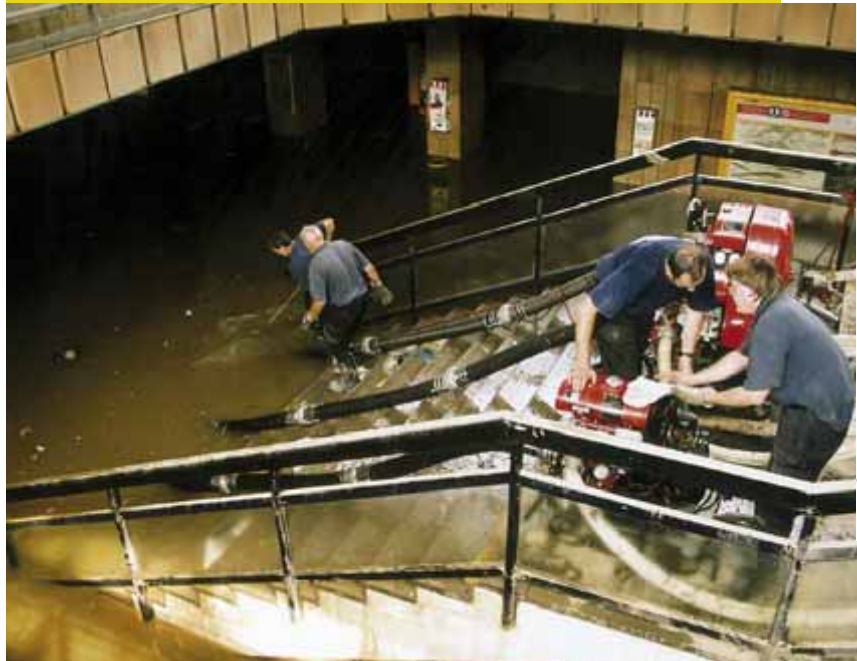
Čerpání vody z Vltavské, vyčerpáno se podařilo přibližně po týdnu od středy 14. srpna.
