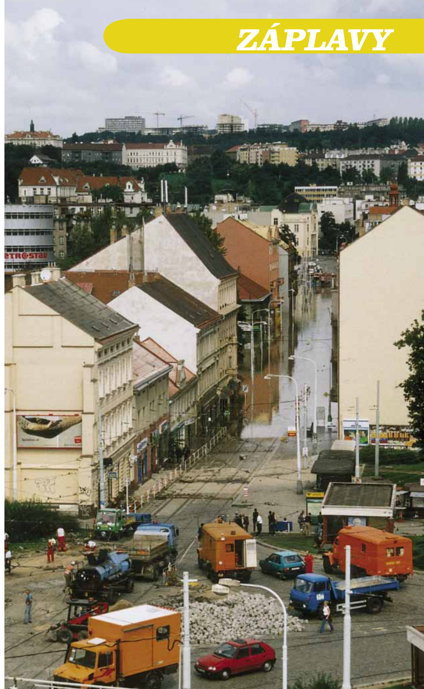
↕ Křižovatka Palmovka, kterou kromě vody sužovaly i rekonstrukční práce na tramvajové trati přes Libeňský most.
