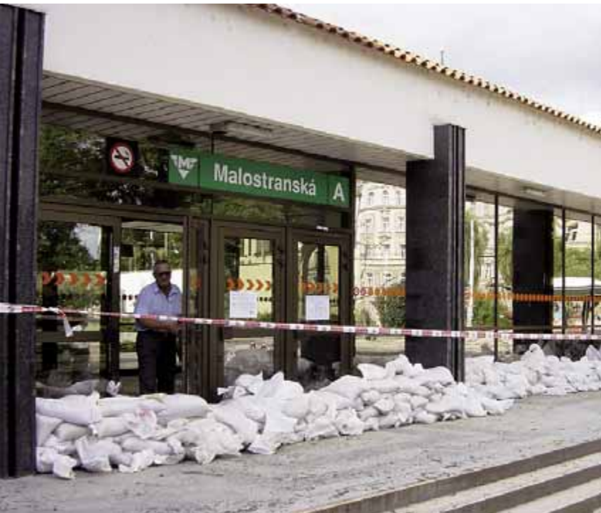
Protipovodňová ochrana (pytle s pískem) ve stanici Malostranská.
