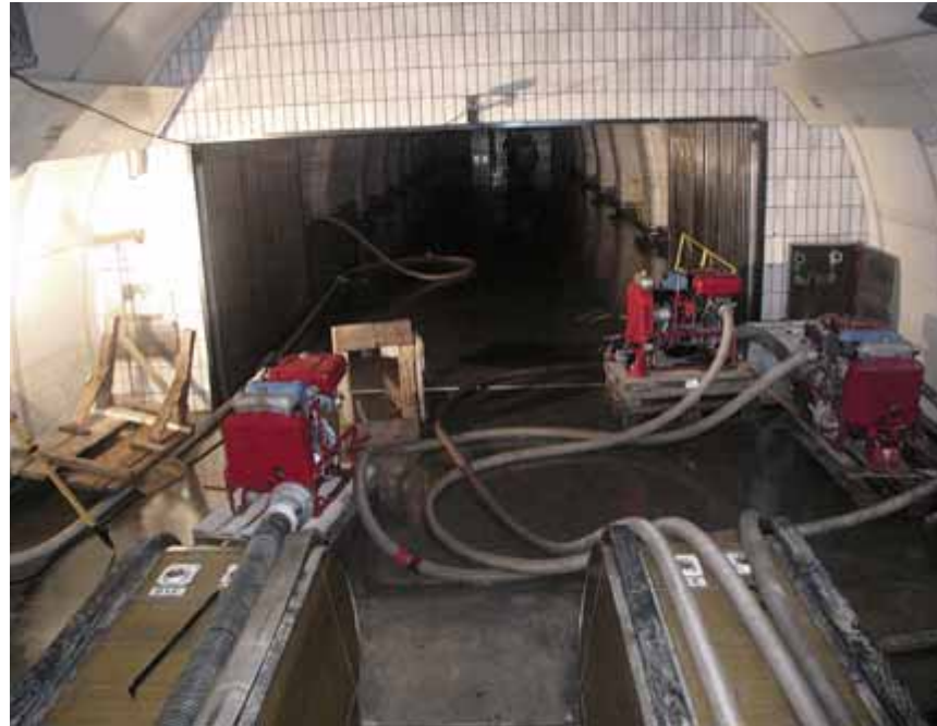
Motorová čerpadla, bohužel, ve druhé polovině srpna nezbytné vybavení některých stanic metra. Na snímku se čerpá ve stanici Českomoravská.
