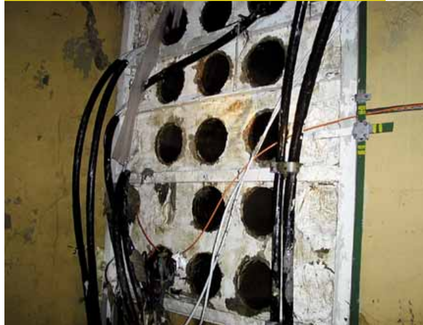
Vyražené tlakové ucpávky ve stanici Palmovka po nezané vodní návštěvě.
