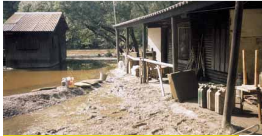
Stejně jako na ostatních místech u nás i v Nuzičích se po opadnutí vody objevily nánosy bahna.
