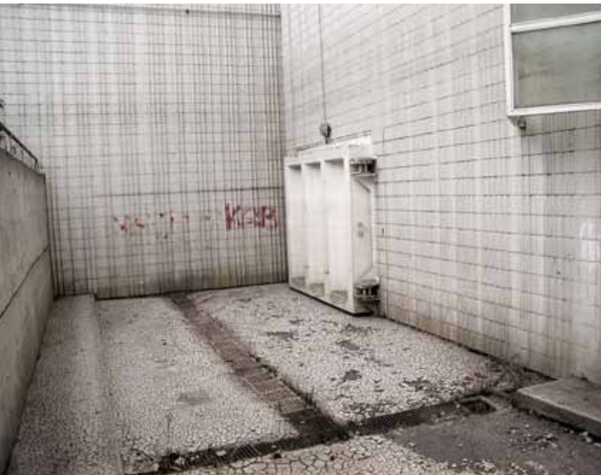
Protipovodňový ruční uzávěr ve stanici Invalidovna nápor vody vydržel.
