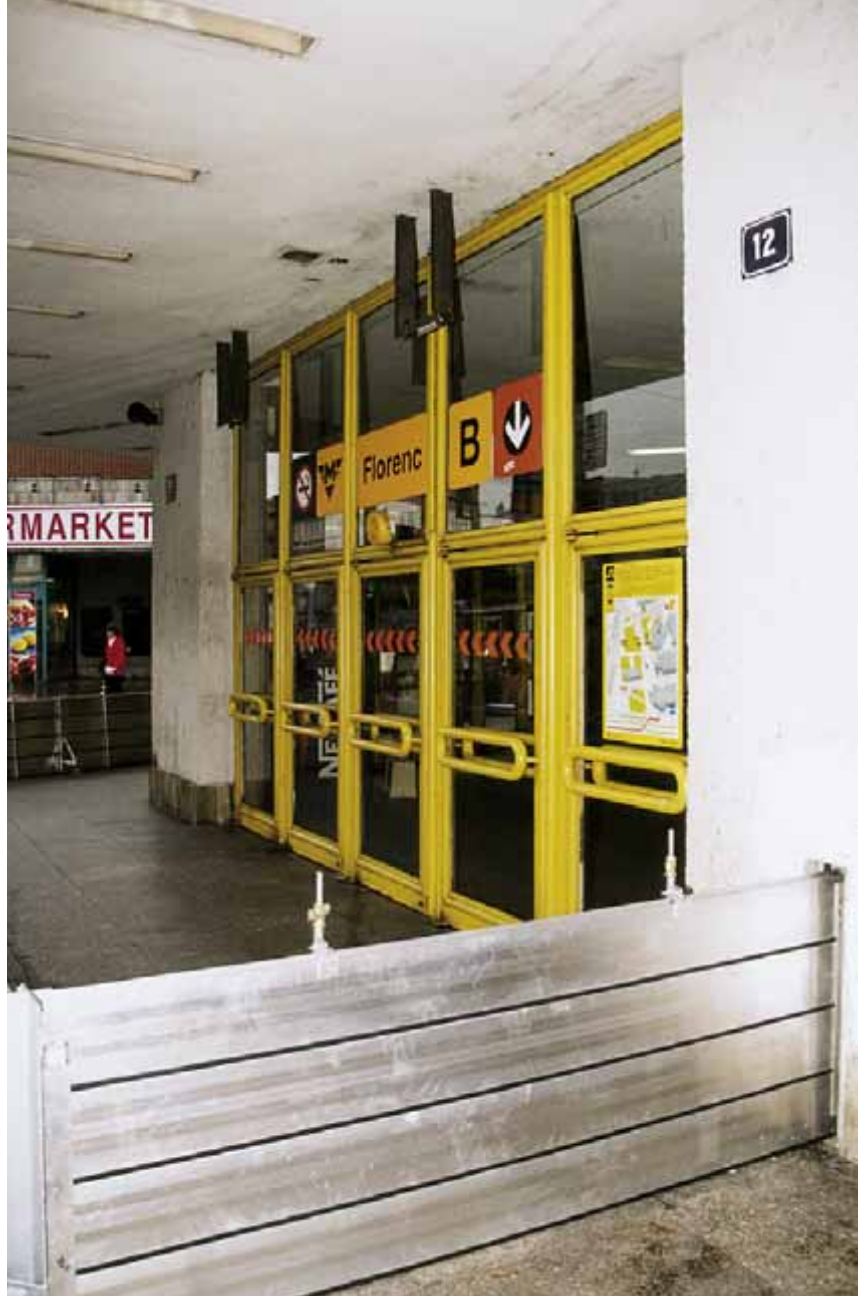
Rovněž u ohrožených stanic metra byly postaveny protipovodňové stěny, stejně jako na Smetanově nábřeží. V případě stanic metra dosáhla hladina o 1,5 až 2 metry výše, než byla výška stěn proponovaná na stoletou vodu.
