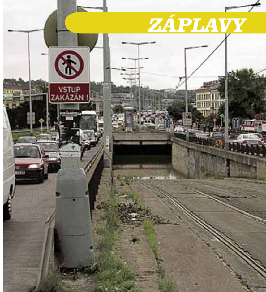
Z Hlávkova mostu na Těšnov už se tramvají nedostanete, podjezd magistrály je zatopen.
