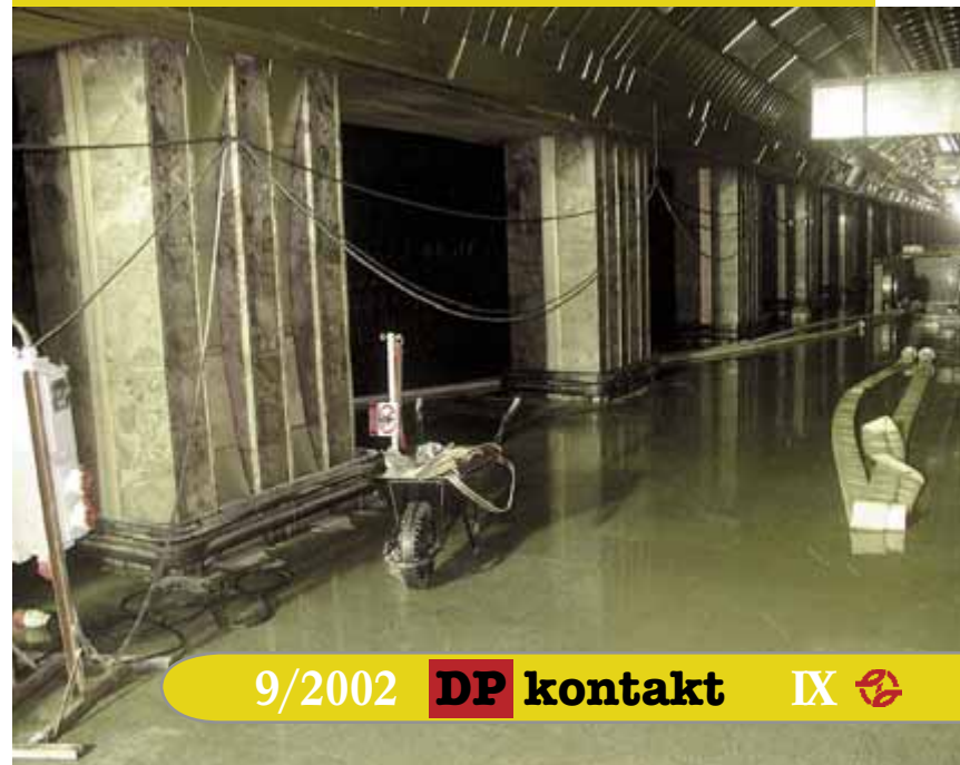
Stanice Můstek na trati A, krátce potom co byla vyčerpána voda.
