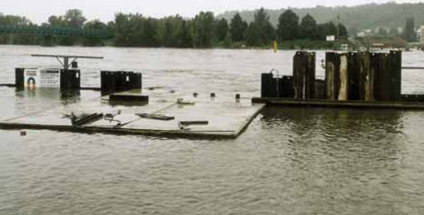
Ještě jeden obrázek ze stavby metra v Holešovicích, voda stoupá.
