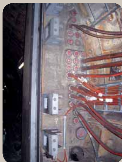
Kontrola těsnění kabelových průchodků po vyhlášení II. stupně povodňové aktivity
