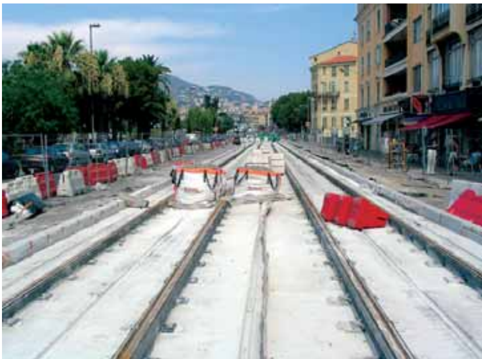
Staveniště první linky poblíž zastávky Garibaldi v centru města ve stavu z července 2006. Foto © Filip Drápal
