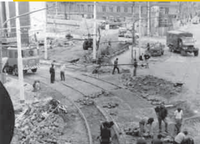
Tak vypadaly stavební práce ze železničního mostu. Pro budoucí automobilovou magistrálu stojí v pozadí zatím jen pilíře a ve stavbě je i nájezdová rampa.
