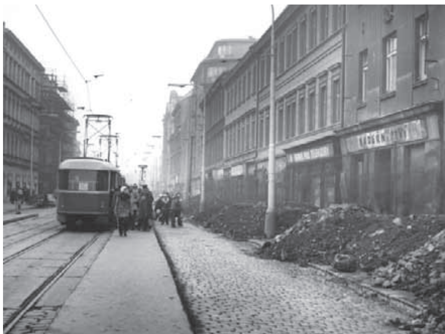
Nádražní ulice mezi Plzeňskou a Bozděchovou, rovněž den před demolicí. „Anděl zmizel v oblacích,“ napsala Večerní Praha o den později. Osud domu U zlatého anděla a jeho sousedů se naplnil v sobotu 16. února 1980 v 9 hodin. (Snímky z demolice si můžete prohlédnout v knížce 30 let pražského metra na straně 86). Foto: Archiv DP
