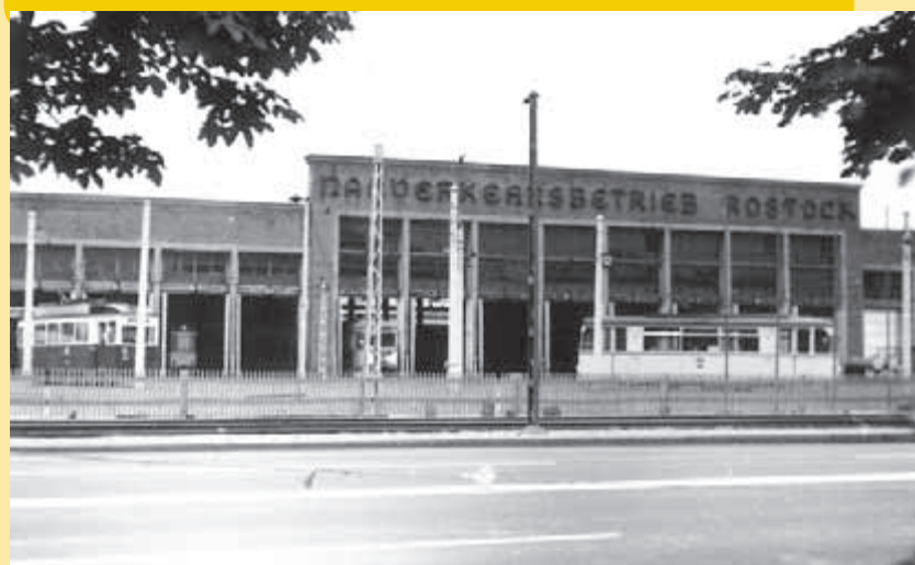
Vozovna na Hamburger Strasse byla postavena v roce 1956 pro 32 třívozových souprav. Takto vypadala v létě roku 1972. Foto: Jan Dvořák
