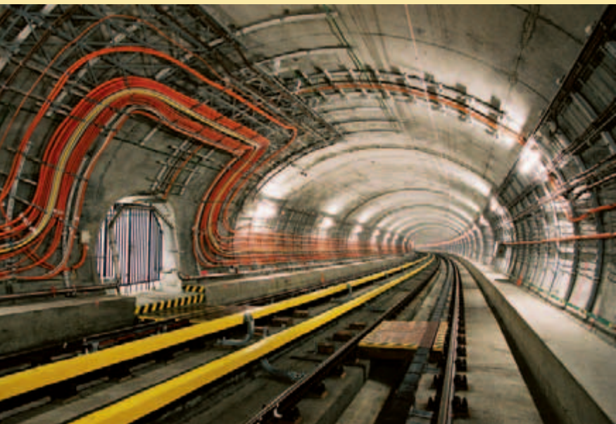
Dvoukolejný traťový tunel.
