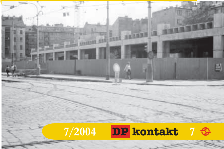
Alespoň jedním snímek z roku 1984 si můžeme připomenout křižovatku těsně před zahájením rekonstrukce Nádražní ulice, při které se tramvajové koleje posunuly o něco západněji. V té době se už rýsovala za ohradou hrubá stavba obchodního pavilonu a budoucího vestibulu metra. Foto: Pavel Fojtík
