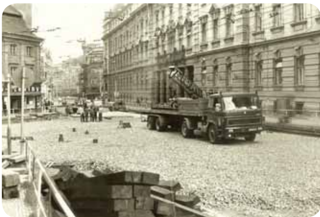
Na části křižovatky Myslíkova – Spálená se v létě 1984 prvně instalovaly v Praze VÚIS panely. Foto: Archiv DP
