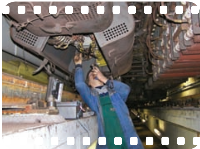
Provozní ošetření soupravy ve „Stanovišti provozního ošetření“ Černý most (SPO CM). Foto: Jiří Tonar
