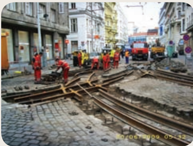
V sobotu ráno již byly staré kolejnice vyvezeny a začala montáž nových. Foto: Tomáš Šilhan
