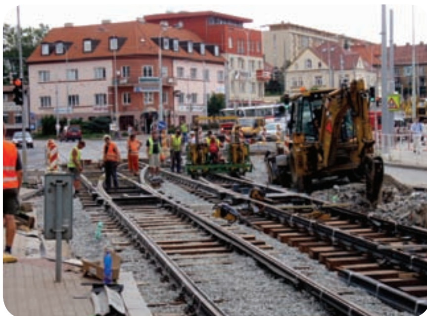
Rekonstrukce křižovatky Střelnická – Klapkova v druhé etapě dne 7. července 2009.
