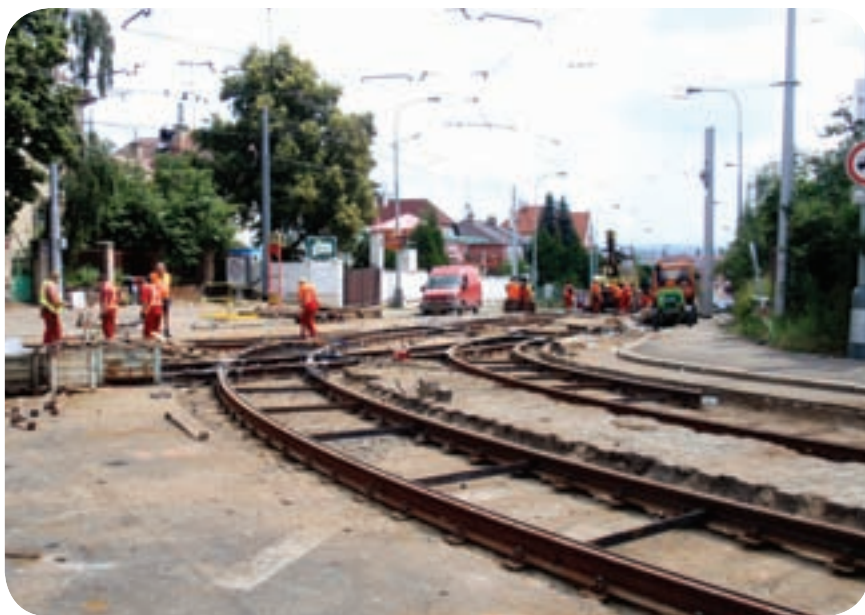
Výměna kolejové konstrukce před vozovnou Kobylišy v režii Vrchní stavby.
