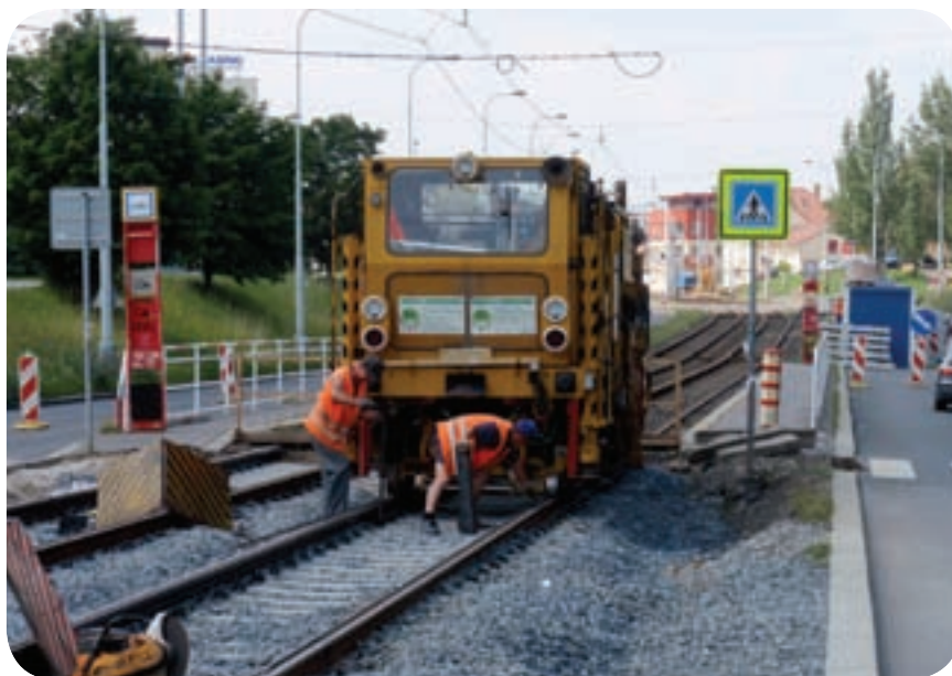
Rekonstrukce trati do Ďáblic. Na snímku je vidět hranice úseku rekonstruovaného v roce 1993 a nyní. V pozadí probíhá rekonstrukce zastávek Střelnická.
