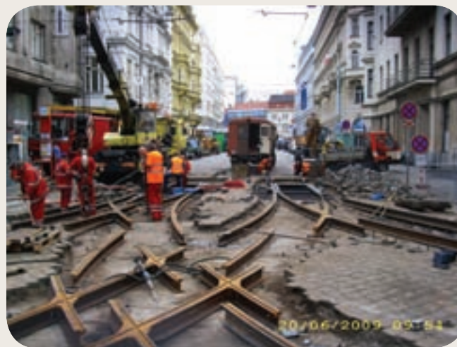
Pár hodin poté jsou již usazeny výhybky na nových pražcích. Foto: Tomáš Šilhan
