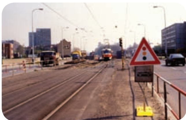
Rekonstrukce úseku Ládví – přejezd Střelničná – Střekovská. Na snímku z 5. května 1994 zaujme signalizační zařízení jednokolejky.
