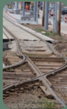
Provizorní napojení rekonstruovaného úseku u povrchového přejezdu Kalifornien. Foto: Jan Šurovský
