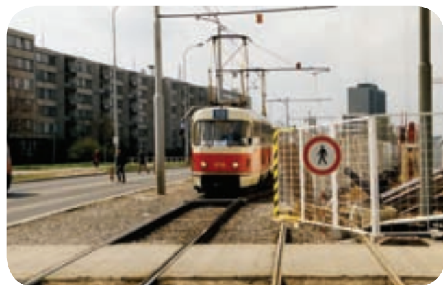
Další jednokolejka na Ládví, tentokrát kvůli stavbě metra IV.C1, byla dokumentována 19. dubna 2002.
