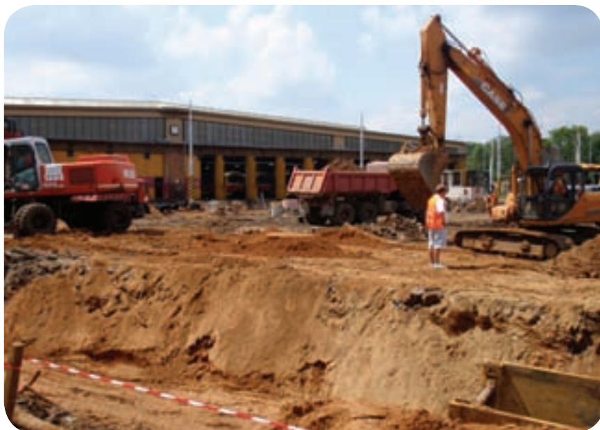
O tři dny později již byl dvůr k nepoznání a plný stavebních strojů, které z haly sledují na 2 měsíce uvězněné tramvaje.
