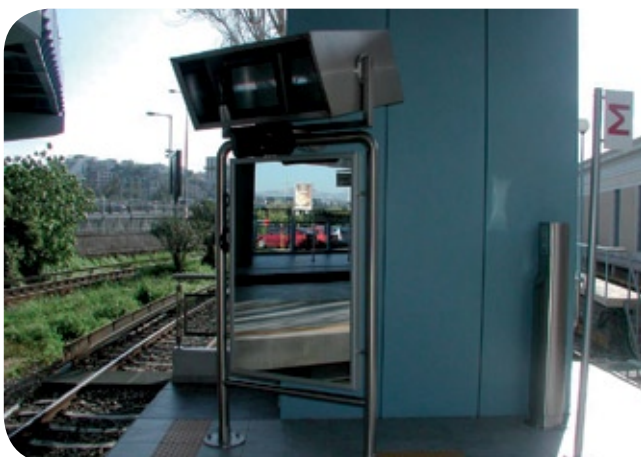
↑ Zde je vidět prvek typický pro stanice trasy 1. Je to velké zrcadlo nad ním nerezová krabice s dvěma obrazovkami pro strojvedoucího, aby měl přehled, co se děje na peroně.
