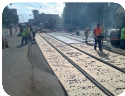
Provádění litých asfaltů.
