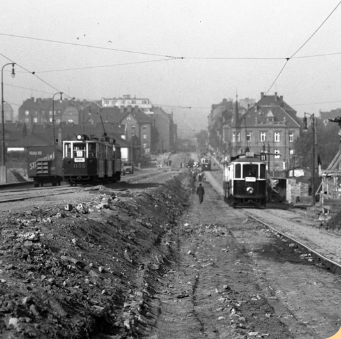
Rekonstrukce tratě na podzim 1937. Směrem na Špejchar tramvaj jede po nové koleji, vpravo ještě po staré trati.
