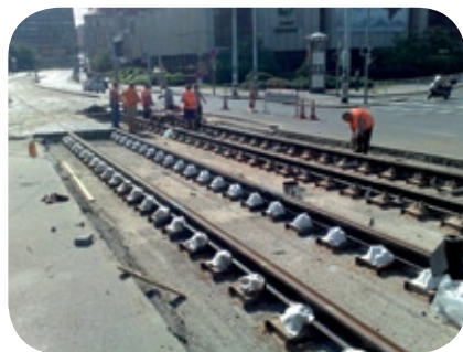
Upevnění kolejnic do betonové desky.
