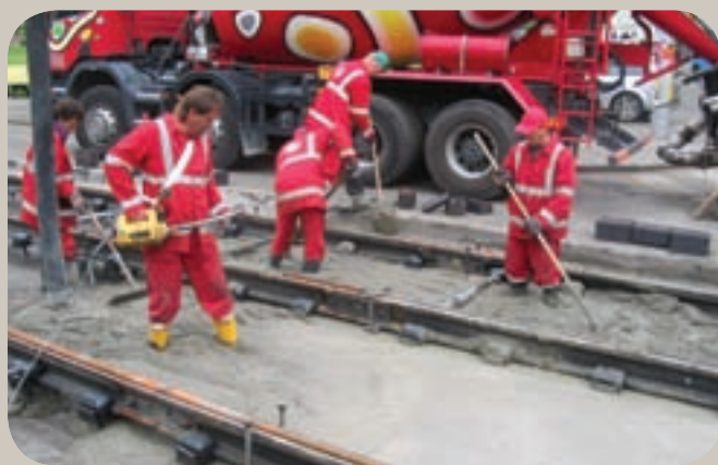
Zabetonovaný W-tram. Foto: L. Sarnovský
