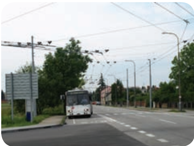
Stavba nejnovější budějovické trolejbusové tratě, vedoucí do Českého Vrbného, byla ze 75 procent zaplácena z Evropského fondu pro regionální rozvoj.
