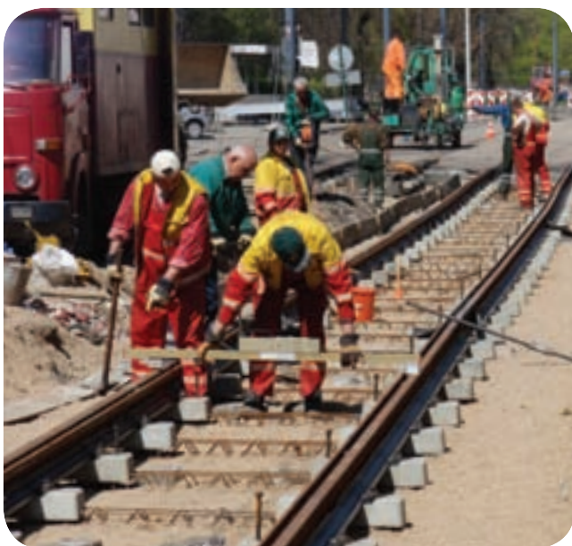
Rekonstrukce trati v Mlynarskiej ulici probíhá s využitím systému Rheda-City, známého např. z Berlína nebo Drážďan.
