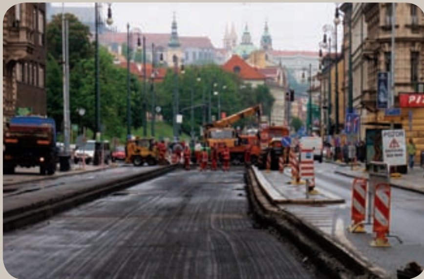
Připravený prostor pro betonovou desku. Foto: Jan Šurovský
