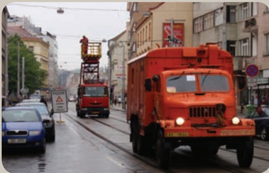
V celém úseku byla zrekonstruována také trolej. Foto: Jan Šurovský
