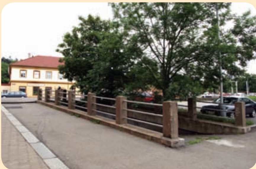
V roce 1948 byl pod Bělohorskou třídou zřízen podchod. První v Praze.
