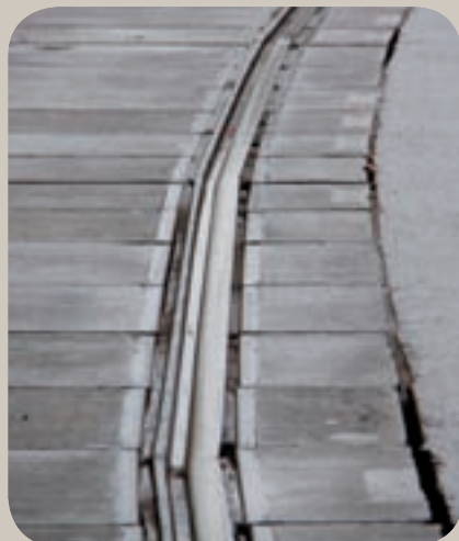
Rozlámaný oblouk v pěší zóně u Anděla před opravou. Foto: Jan Šurovský
