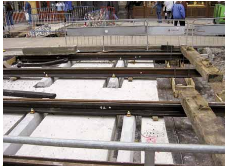
Po připevnění kolejnic k pražcům se provede výškové a směrové vyrovnání. V tuto chvíli je vše připraveno pro zabetonování pražců. Dále bude následovat ještě jedna vrstva betonu a nakonec povrch z litého asfaltu.
