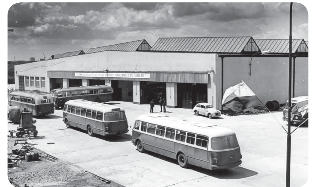
Najždění autobusů Škoda 706 RO do ne úplně dostavěných garáží při slavnostním zahájení provozu na Kačerově 28. května 1966
