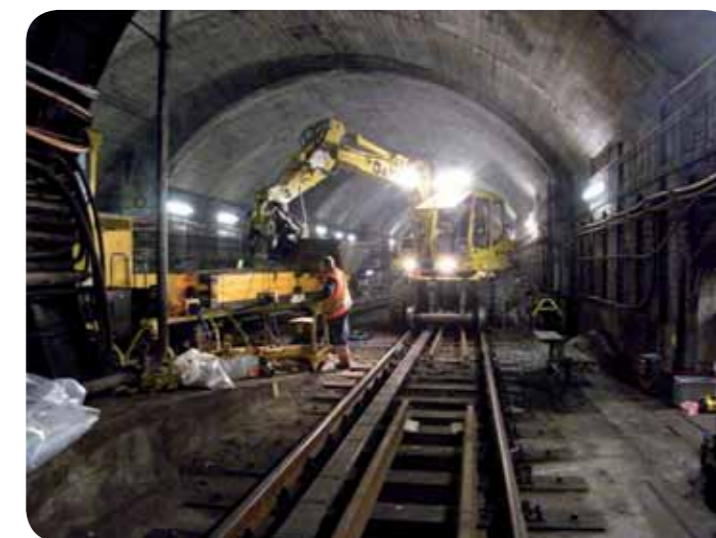
Nasazení dvoucestného rypadla na odtěžení štěrku
