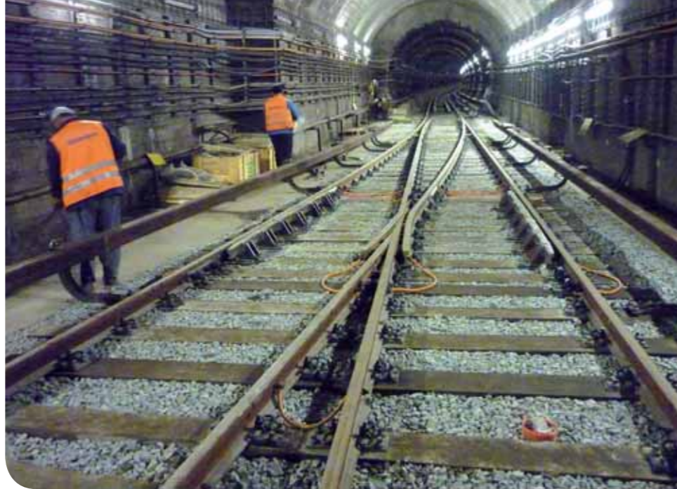
Finální úprava nové výhybky ve stanici I. P. Pavlova s viditelným vstrojením vodivými měděnými propojkami
