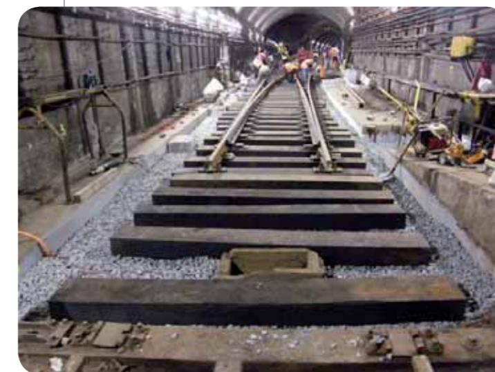
Montáž výhybky 1. generace ve stanici I. P. Pavlova
