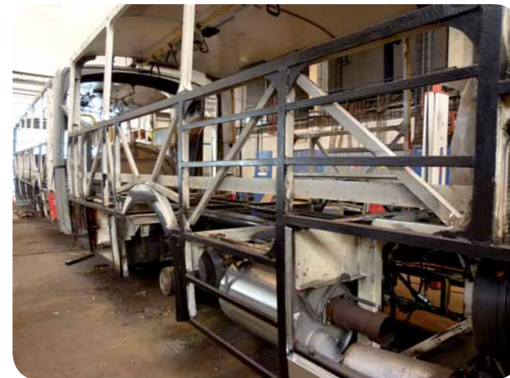
Zadní část neboli vlek kloubové Karosy ve stavu před oplechováním po výměně vadných konstrukčních částí
