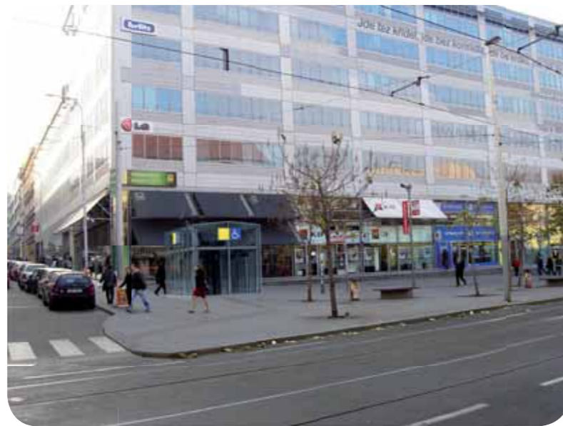
Zákras do fotografie představuje bezbariérové zpřístupnění stanice metra Anděl
