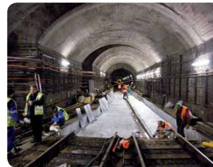
Penetrace podkladních betonů a zakrytí odvodňovacího žlabu
