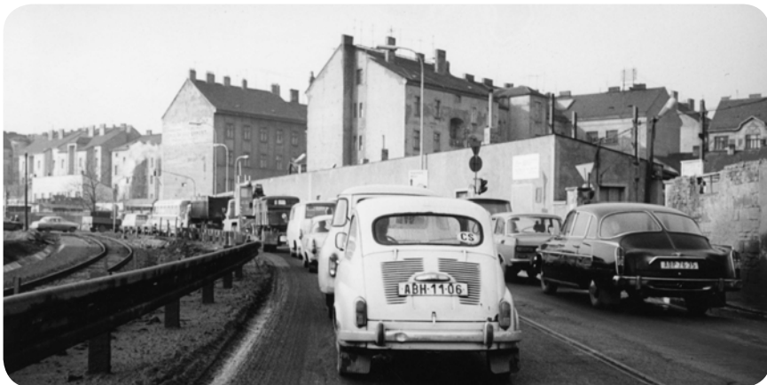
Stejné místo jako na předchozím snímku kolem roku 1980, kdy tudy byla vedena objížďka při rekonstrukci Argentinské ulice. Přístavní dráha je už přeložena do nové polohy (vlevo), ale původní koleje ještě dlouho zůstaly v zemi. Foto: Archiv DP
