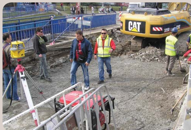
Vyplněno, nad tratí se může začít s prováděním konstrukce tramvajové trati.
