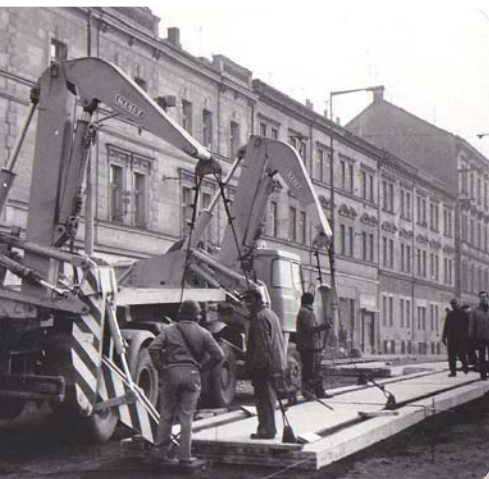
Do skupiny autojeřábů lze zařadit i tento ukladač panelů BKV. Vidíme ho přímo v akci v ulici U Výstaviště na křižovatce s Bubenskou ulicí. 20. března 1979
