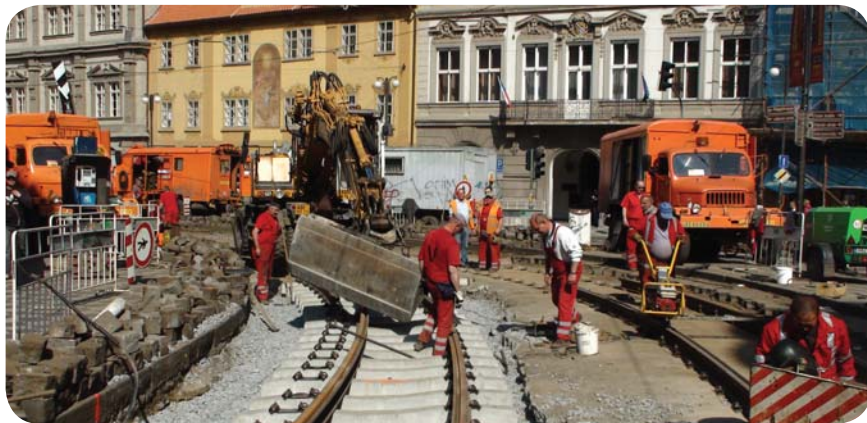
Instalace trati na nových pražcích. Foto: Jan Šurovský
