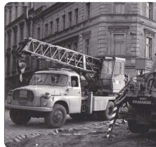
Autojeřáb ADK 125 originál výroba NDR podvozek i nástavba, tj. vlastní vozidlo ADK. Motor byl (jak jinak) IFA 6 válec. Kabina jeřábníka byla součástí kabiny řidiče a ovládání pomocí otočného sedadla. DP Technické služby vlastnil 4 tyto vozy. Fotografováno na Letné 1. května 1977.
