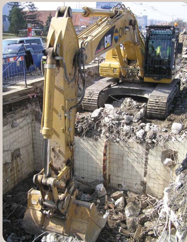
Vlevo byla pánská část toalet, na pravé straně dámská. Z objektu už jsou patrné jen obvodové stěny.
