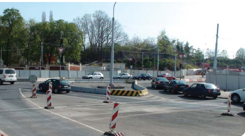
Situace na Prašném mostě se mění ze dne na den. Přes ještě nedokončený provizorní trojúhelník pokračují automobily na již přes rok odpojené torzo staré křižovatky.
