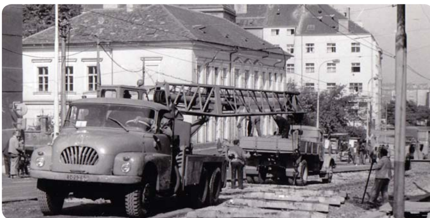
Názorný příklad použití autojeřábu v praxi. Tatra 138 při nakládání pražců ze zrušené provizorní tratě na Tábořské ulici v blízkosti stanice Na Paloučku. 27. září 1970
