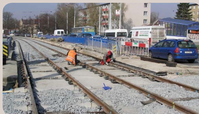
Nad podchodem dokončuje Skanska upevnění kolejnic na betonovou desku. Mezi výstupy z podchodů jsou patrné dřevěné pražce.
