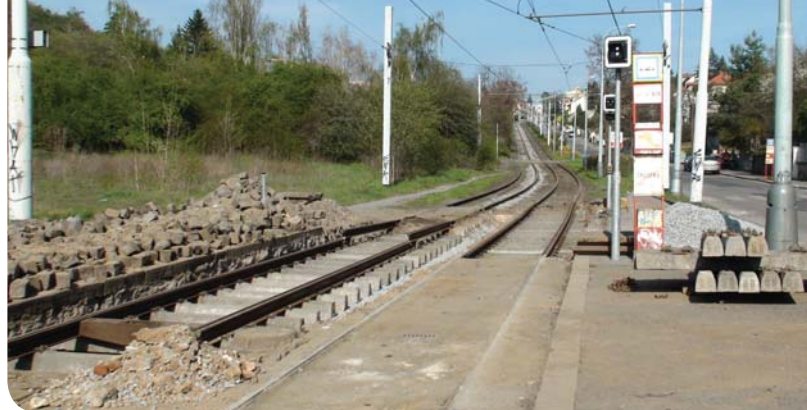
Probíhající výluky využila JDCT pro opravy trati v Trojské ulici a k likvidaci kolejové spojky v zastávce Nad Trojou.
