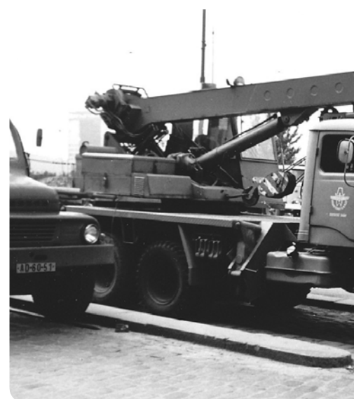
Celkem běžný obrázek v dané době. Autojeřáb na podvozku Tatry 111 přivezl na přívěsu nové křížení pro výměnu kolejové konstrukce na Václavském náměstí. 5. srpna 1972
