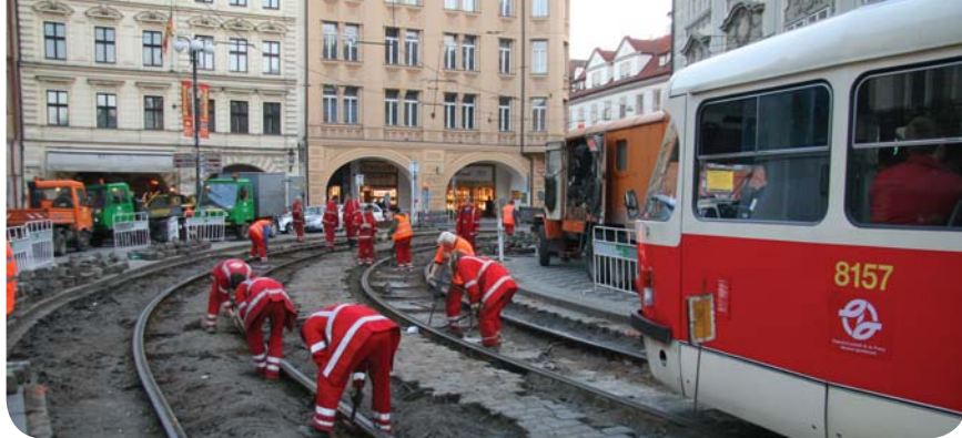
Přípravné práce probíhaly za omezeného tramvajového provozu.
