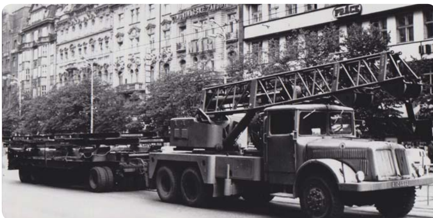
Celkem běžný obrázek v dané době. Autojeřáb na podvozku Tatry 111 přivezl na přívěsu nové křížení pro výměnu kolejové konstrukce na Václavském náměstí. 5. srpna 1972
