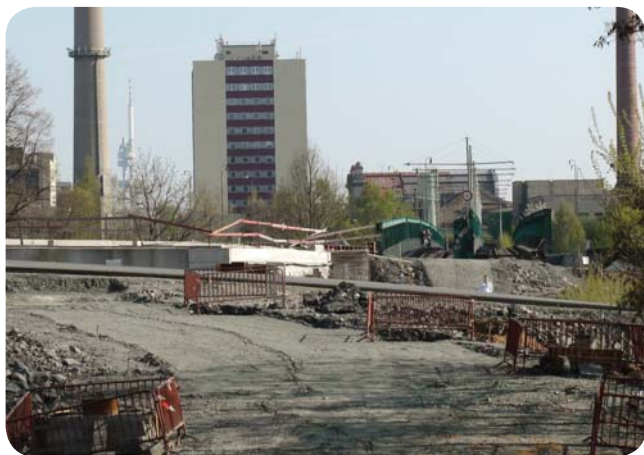
Pravý most je již přizvednut a každý si může porovnat rozdíl o kolik. V levé části snímku se rýsuje trasa pro jednokolejnou přeložku.
