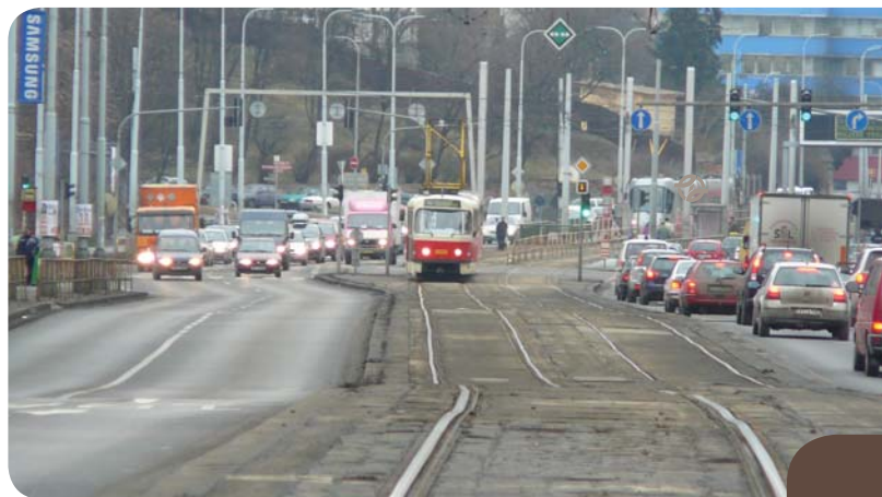
Plzeňská mezi Kotlářkou a Kavalírkou je poslední zcela původní panelový úsek trati z roku 1979.
