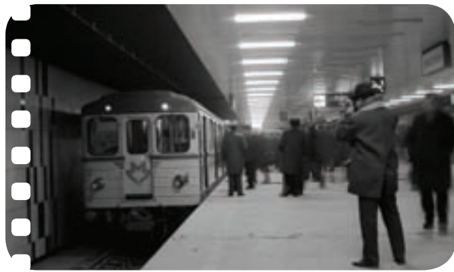
A to už slavnostní zahájení provozu dospělo až do stanice Sokolovská. Jak je vidět, fotografů zde bylo víc, včetně oficiálních zástupců tisku. Na snímku je opět i několik „duchů“. Ostatně, i ten, kdo fotografuje dnes moderními digitálními přístroji, se s tímto jevem běžně setkává, i když si může zvolit citlivost, která u klasického filmu nepřipadala v úvahu.
