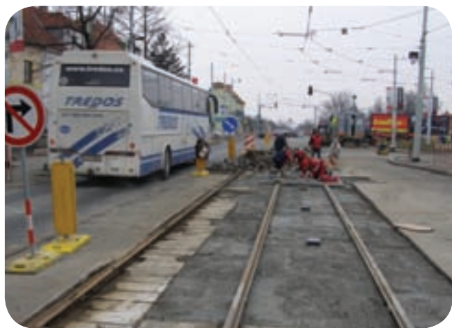
Montáž rádiově ovládané výhybky s kolejovými obvody.
