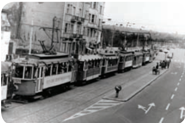
Pohled na severní předmostí Hlávkova mostu také připomíná, jak se Praha proměnila. „Byly jsme svědky pražské historie,“ oznamuje nápis na motorovém vozu 2238.
