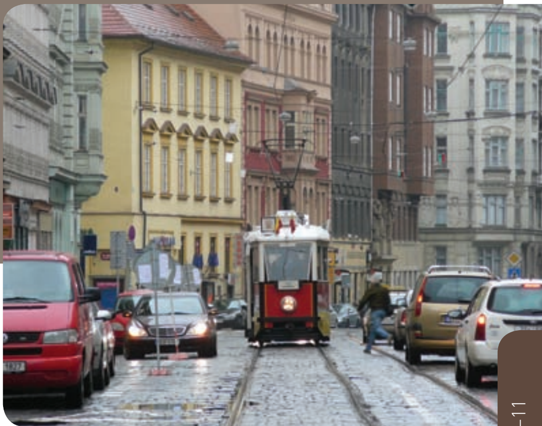
Trať v Myslíkové ulici v listopadu 2008 již s obnoveným trolejovým vedením.
