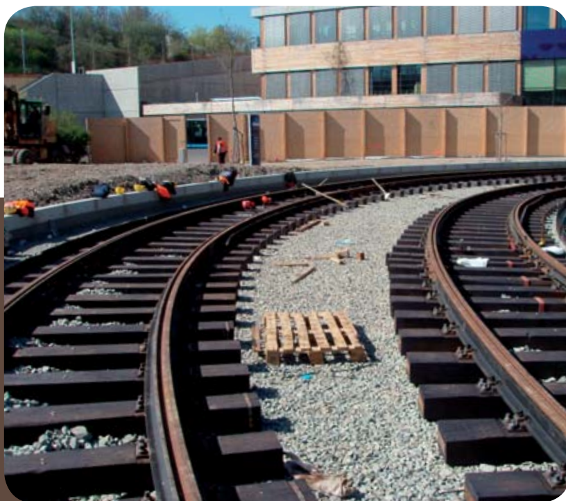
Část budoucí smyčky před budovou ČSOB, pohled od budovy sociálního zařízení řidičů tramvají
