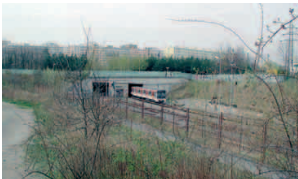
Souprava vjíždí do tunelu, v pozadí je sídliště Skalka. V těchto místech nad zhlavím by v budoucnu mělo být přemostění, jako součást vnitřního městského okruhu.
