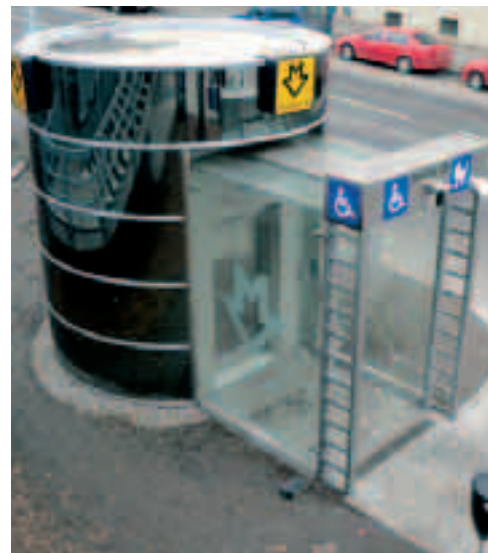
Výtah ve stanici Florenc B.
