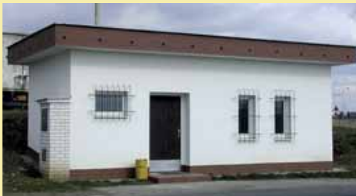
Nové typové sociální zařízení o rozměrech 8x4 metry na obratišti Sídliště Libuš.
