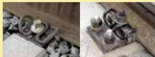
Upevnění kolejnice na železobetonový pražec pomocí svěrky Skl 14 (Černokostecká ulice) (foto vlevo)
