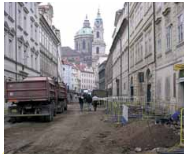
...dohlíží kostel sv. Mikuláše na probíhající zapojování nových domovních přípojek v okolí křižovatky ulic Tržiště a Karmelitská
