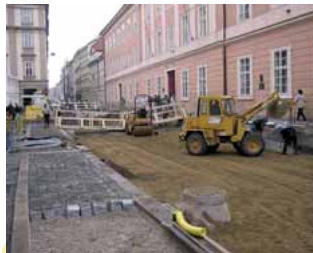
Zatímco se v blízkosti komplexu ministerstva školství ukládají betonové prefabrikáty pro uložení svislých antivibračních rohoží...
