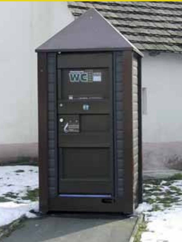
Nové typové sociální zařízení o rozměrech 6x3 metry na obratišti Koleděje.
