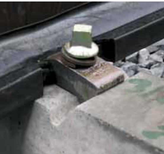
Detail svěrky, navržené firmou Ortec pro upevnění kolejnic přes patní pryžový profil téže firmy.
