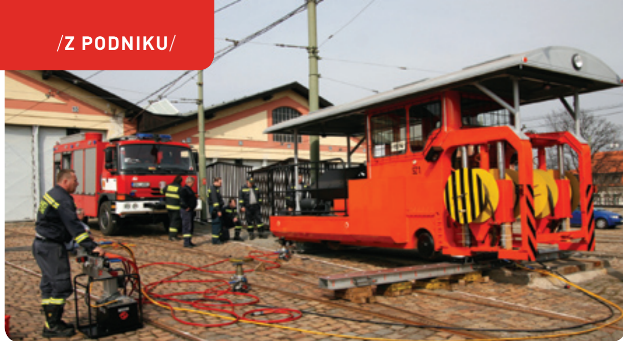
Strojní zatlačovačka se pomalu sune na podstavec
