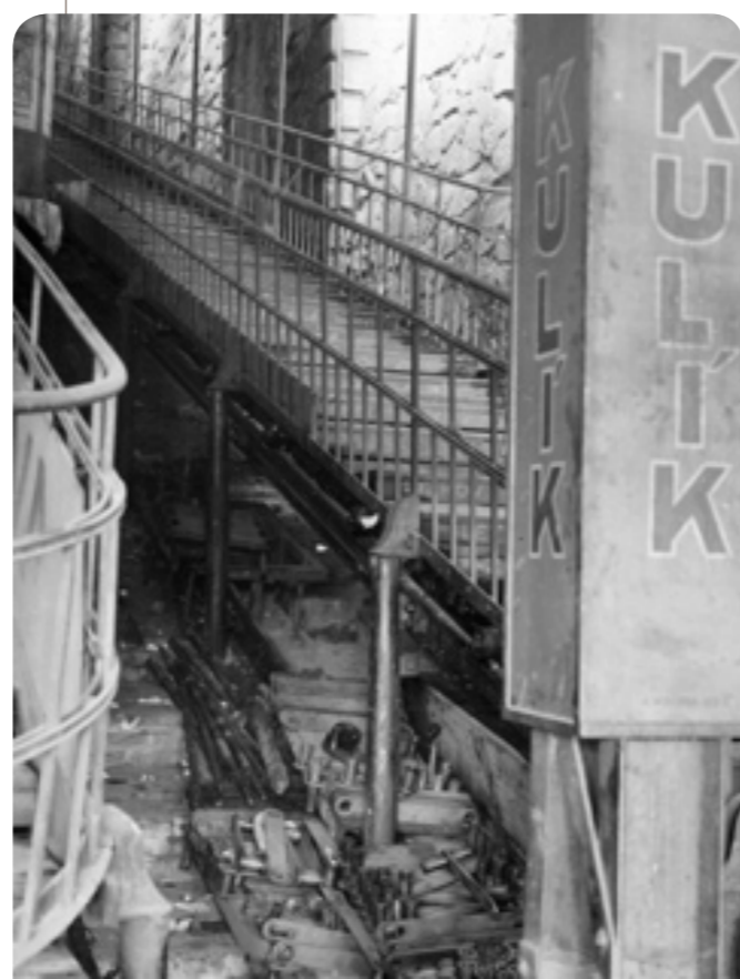
V tak zuboženém stavu přebíraly Elektrické podniky pohyblivý chodník v srpnu 1935
