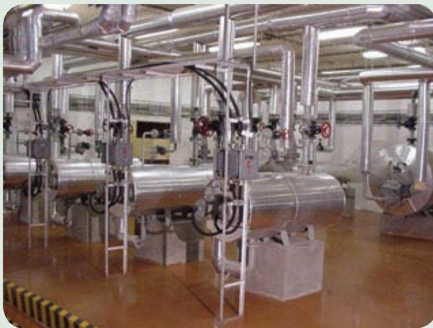
Pohled na podzemní prostory energocentra objektu ZTC3 (základní technické centrum). Toto zařízení bylo projektováno jako náhradní zdroj elektrické energie v režimu OSM pro část trasy B při předpokládaném zničení elektráren a poškození přenosové soustavy. Nyní je počítáno i s využitím pro potřeby DSM. Instalovaný výkon 5 x 1,5 MW.
