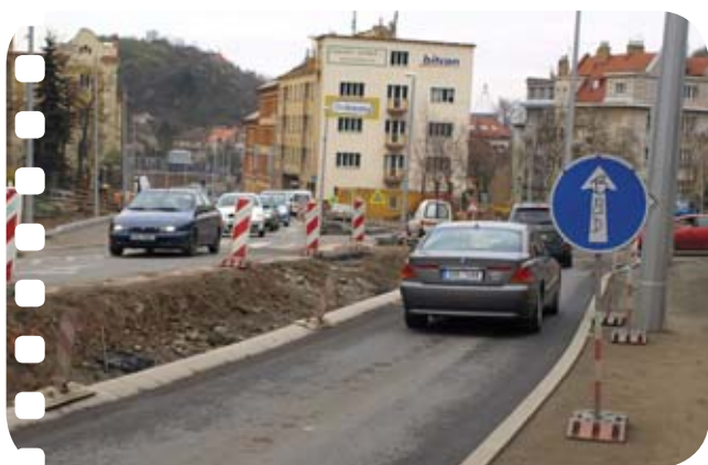
↑ Na tomto snímku je dobře vidět, že nová vozovka bude proti současnému stavu o něco nižší než ta původní. V parku, který je trochu vidět vzadu vpravo, bývala do roku 1983 původní tramvajová konečná.
