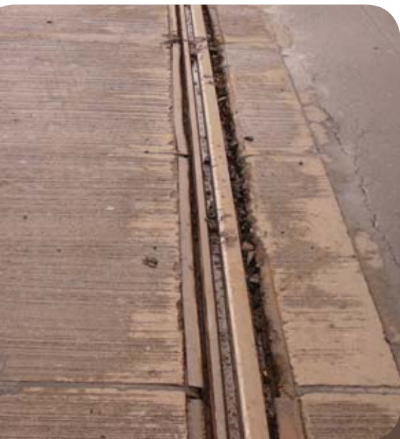
↑ Panely z 90. let mají téměř vždy vyhnílé žlaby, ve kterých kolejnice drží jen zázrakem. Nábřeží E. Beneše, březen 2008.
