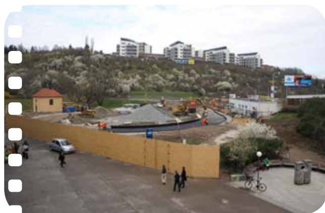
↑ Tak vypadala budoucí konečná nového tratového úseku u stanice metra Radlická 3. dubna 2008. Kaplička vlevo je posledním pozůstatkem staré vesnice Radlice, která tu kdysi stávala a byla zbořena při výstavbě metra a nové komunikace na Jihozápadní Město.
