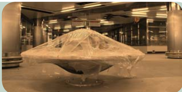
Na závěr „prohlídky“ se všichni ještě prošli konečnou stanicí Letňany, jejíž nástupiště má impozantní šířku 15 metrů. Celková délka stanice je 592 metry. Jediná z nových stanic má nástupiště mezi kolejemi. I zde probíhaly poslední dokončovací práce (nové obložení dostávalo omyvatelný nátěr proti sprejerům). Pokud vystoupáte do vestibulu, budete moci usednout na lavičky, které připomínají létající talíře. Stanice Letňany se nachází jižně od stejnojmenné části města v polích u výstaviště. Na jejím povrchu vyrostl nový autobusový terminál a parkoviště P+R.
