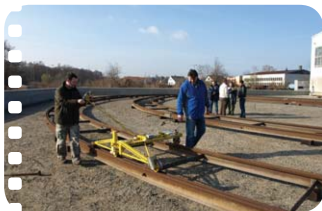
↑ Zhotovené kolejiště budoucí smyčky pečlivě zkontrolovali už 28. února pracovníci Dopravního podniku v areálu Pražské strojírny ve Víněři.
