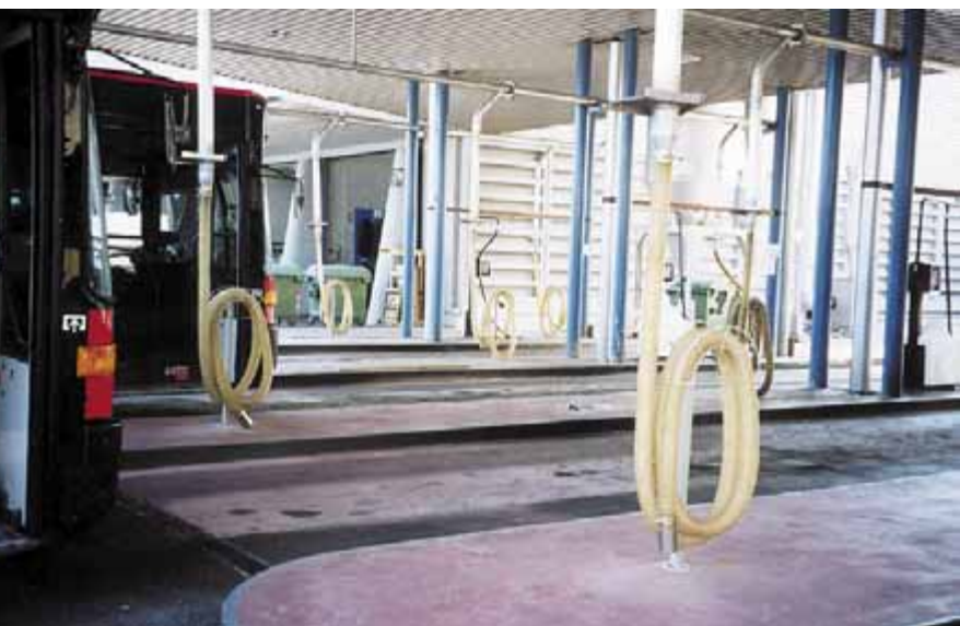
Pevně připojené hadice vysavače. Vysávání probíhá během plnění paliva.
