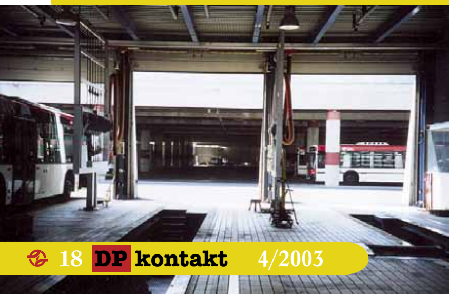
Výjezd z dílny do garáže, garážová vrata nejsou doposud nainstalována. Na podpěrných sloupech rozsáhlé garáže jsou nainstalovány zásuvky pro speciální pojítka, pomocí kterých se každý řidič může spojit přímo s dispečerem.
