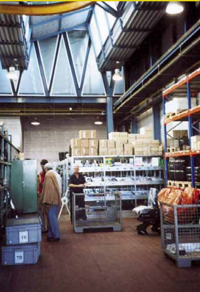
Skład materiálu se žlutou kolejnicí ve stropě pro rozvoz materiálu po dílně.
