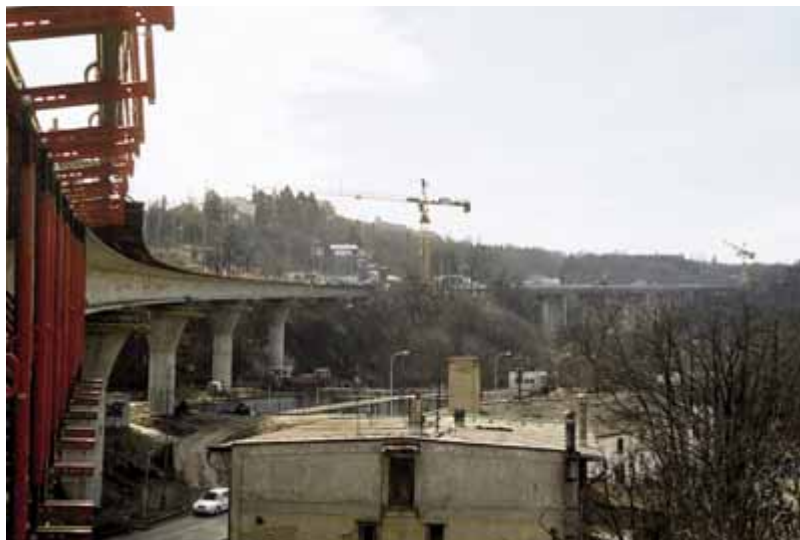
Estakáda tramvajové tratě na Barrandov je téměř hotova.
