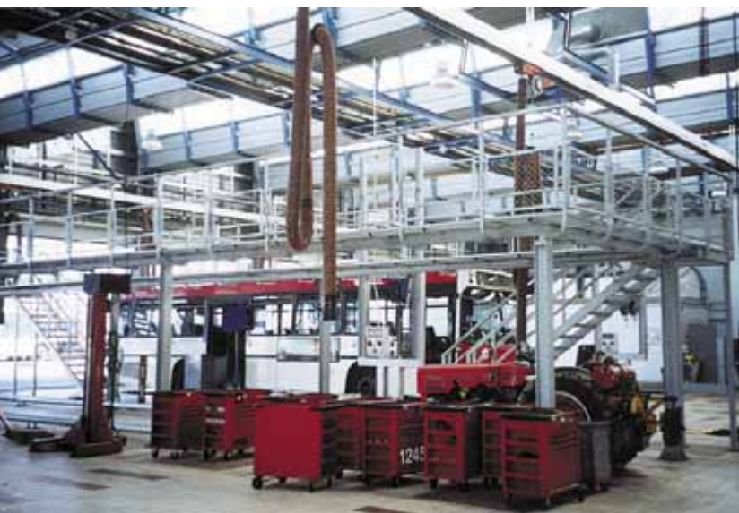
Opravy na střeše se provádějí z rampy.
