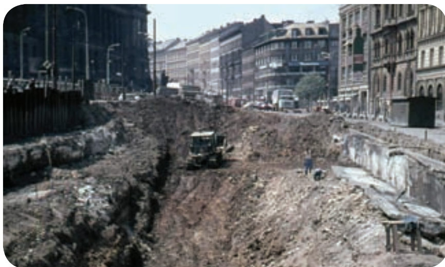
Tato fotografie staveniště stanice Muzeum byla pořízena 30. května 1969. V té době se už stavělo místo podpovrchové tramvaje metro.
