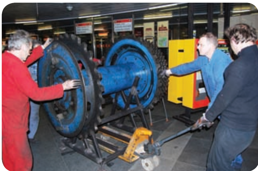
Hřídel je umístěna na speciální „kozou“ a za pomoci vozíku a lidských svalů odvážena k nákladnímu výtahu. V tomto případě se musely demontovat sloupky na začátku přepravního prostoru a demontovat vchodové prosklené dveře do stanice.
