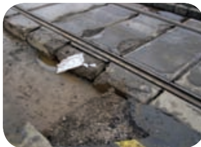
Obnažené BKV panely před podfoukáním a obnovou zálevků.
