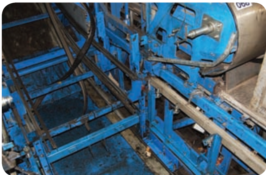
Pohled na opačnou dolní část eskalátoru po demontáži vratného hřídele.
