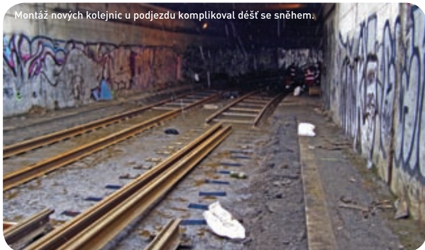
Obnažené BKV panely před podfoukáním a obnovou zálevků.
