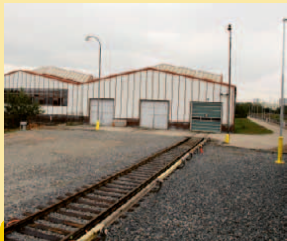
Budoucí staveniště nové stanice metra.
