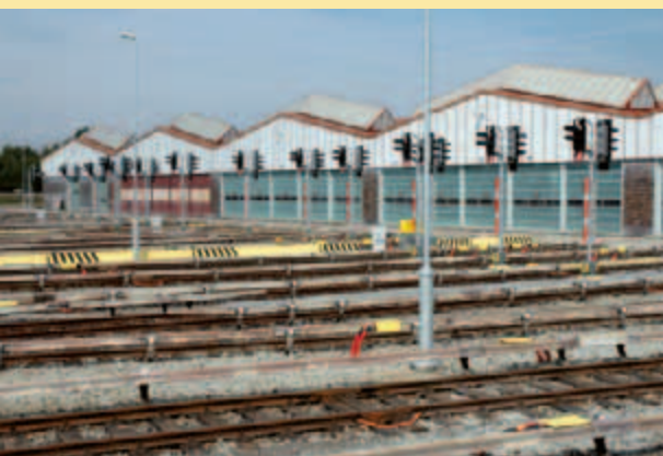
Části rekonstruovaného zhlaví depa Hostivař.
