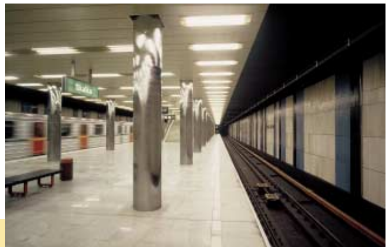
Nástupiště stanice Skalka stavěné za provozu na spojení do depa Hostivař.
