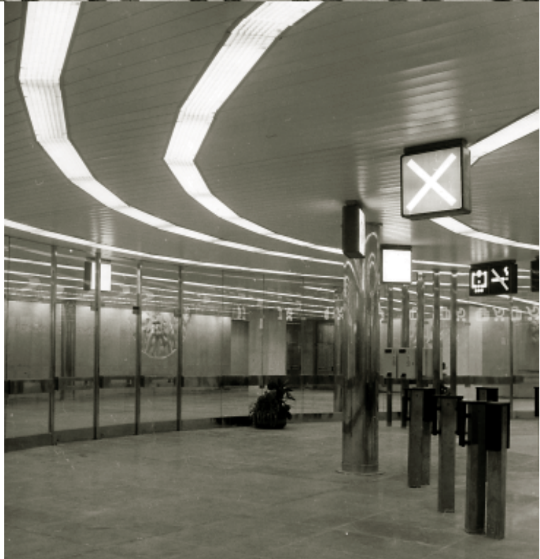
Zdařilá kompozice vestibulu a podchodu stanice Hradčanská.
