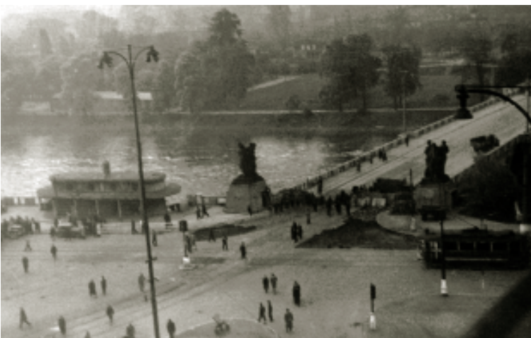
Téměř stejný pohled avšak o 33 let starší. Ti starší z nás si zřejmě vzpomenou na původně úzký Hlávkův most. Od svého vzniku v roce 1912 byl původně široký jen 16 m včetně chodníků a v letech 1958 až 1961 byl výrazně rozšířen. Na snímku, který byl pořízen při květnové revoluci v roce 1945, je vidět původní poloha Štursových sousoší Humanita a Práce i zajímavý pavilon čekárny Elektrických podniků, postavené nad záchodky. V podstavcích sousoší byly původně výběrcí budky mostního, později stanoviště výhybkářů tramvajů a také trafika. Při rekonstrukci byla sousoší z mostu na téměř čtvrt století odstraněna.
