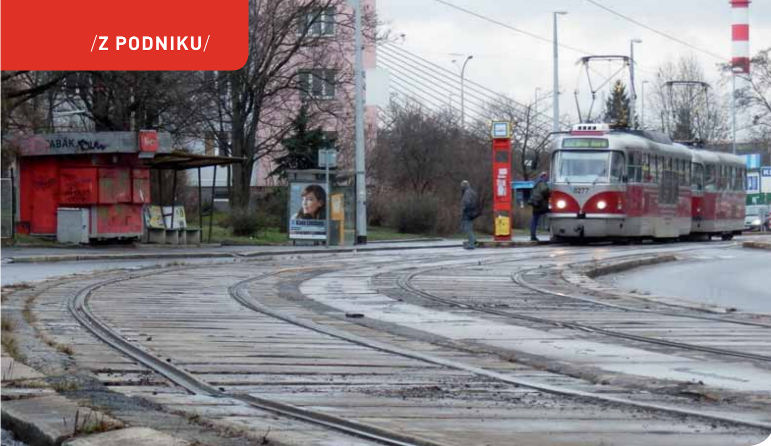
Jedno z nejhorších míst na pražské tramvajové síti: oblouk u zastávky Na Padesátém na trati do Hostivaře
