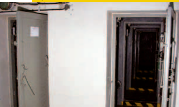
Očistná propust byla určena převážně pro obsluhu. Umožňovala vstup z čisté do zamořené části a naopak. Například v případě nutnosti provést průzkum na povrchu.
