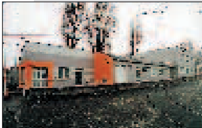
Nová administrativní budova Žižkov.
