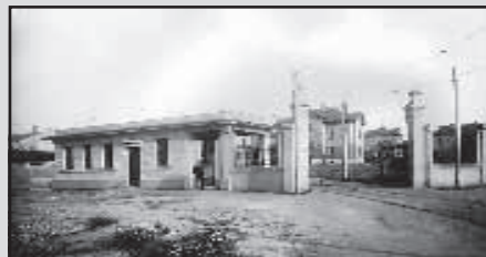
Fotografie z výstavby.
