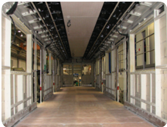
Záběr na připravenou kabeláž a podlahu před pokládkou svrchní vrstvy podlahoviny ALTRIO X25
