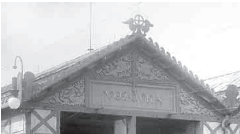
Detail z předchozího snímku ukazuje bohaté ozdoby střechy.
